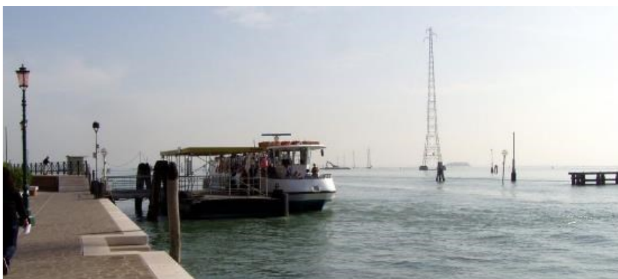
Figura 6.7.3 - Vista approdo di Fusina
