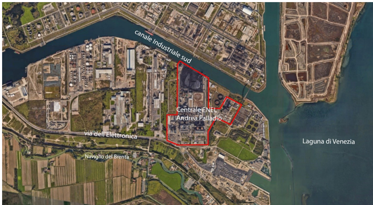
Figura 1.4.2 – Localizzazione della Centrale
