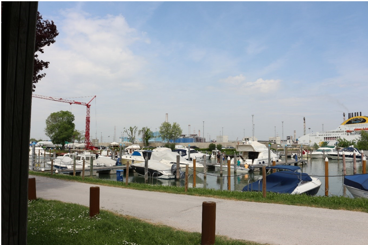
Figura 5.5.3 – Punto di vista 2 – Stato di fatto
