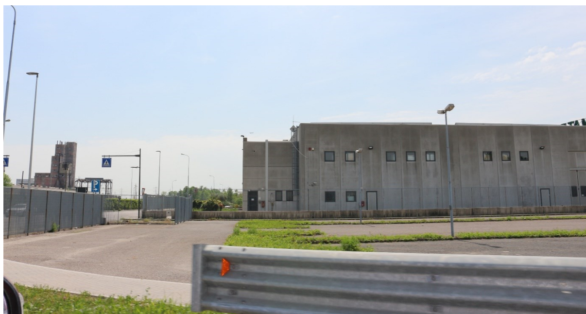
Figura 4.3.7 - Impianti industriali a Fusina
