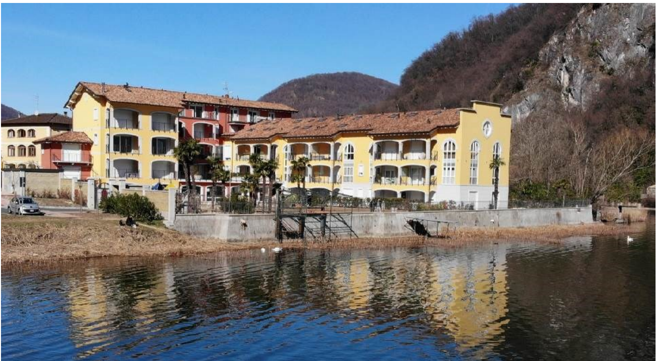
Figura 49 - Stato di fatto della sponda
