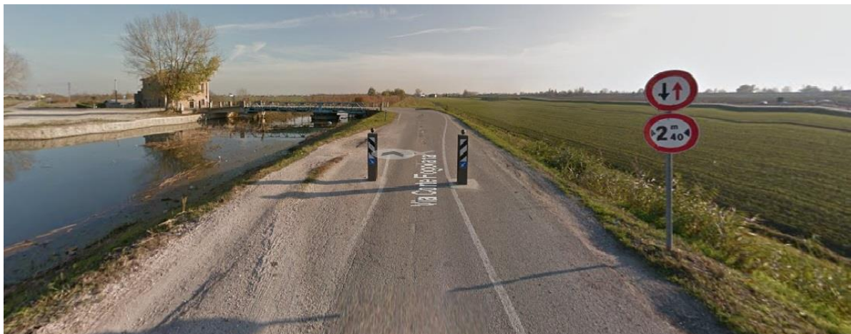
Figura 15 - via Corte Fogolana - innesto con zona delle chiese
