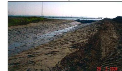
Foto 2 - la Fossetta dei Barambani lato interno durante i lavori
