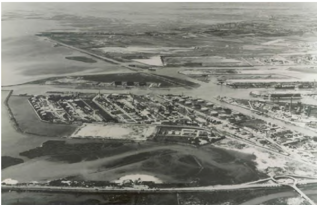
Figura 156: foto della prima Zona Industriale completata sullo sfondo la situazione antecedente le casse di colmata per la seconda Zona Industriale (1960)
