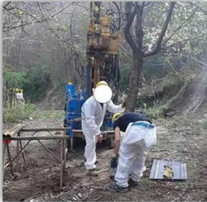
Figura 10-3: Sondaggio effettuato mediante perforazione a carotaggio.
