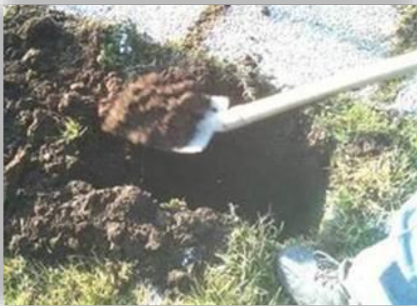
Figura 10-2: Scavi con strumenti manuali
