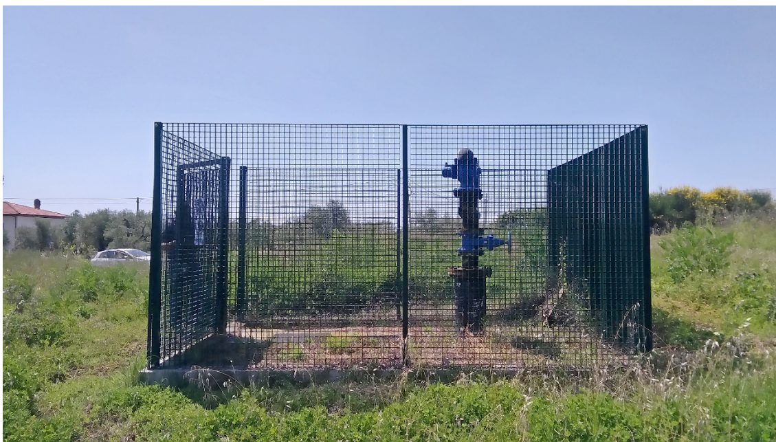
Figura 14 - esempio di manufatto di scarico già realizzato in precedenti interventi.
