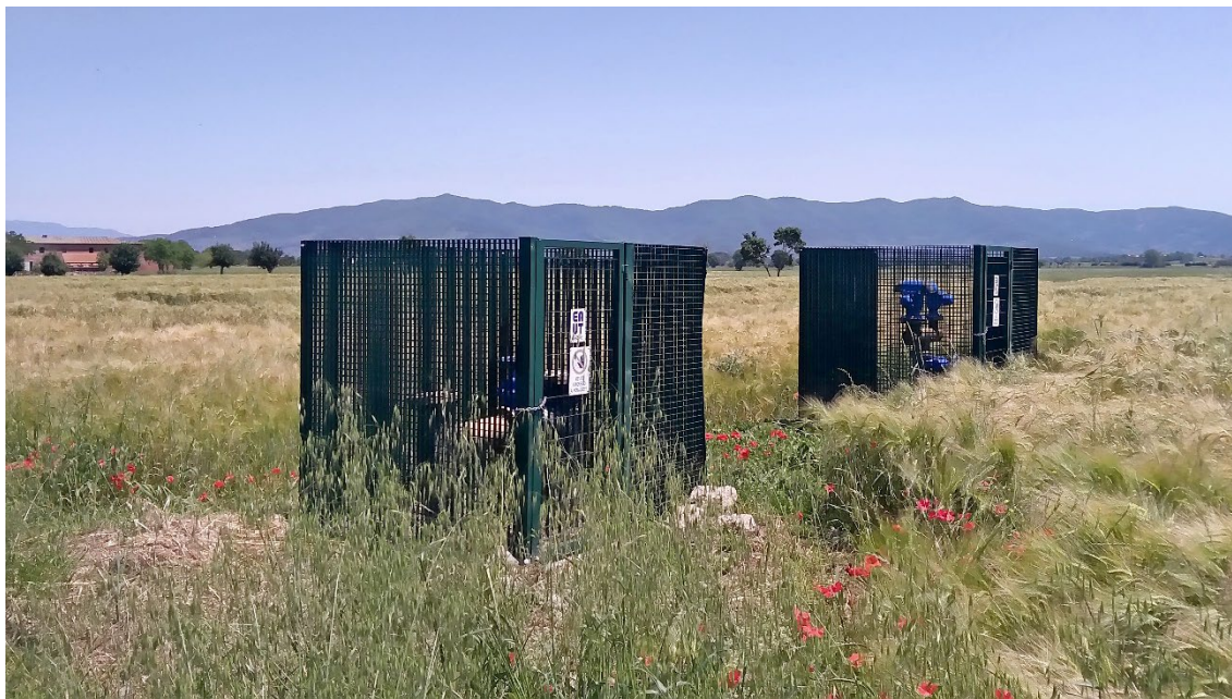
Figura 8 – esempio di manufatto di sfiato realizzato in precedenti interventi.
