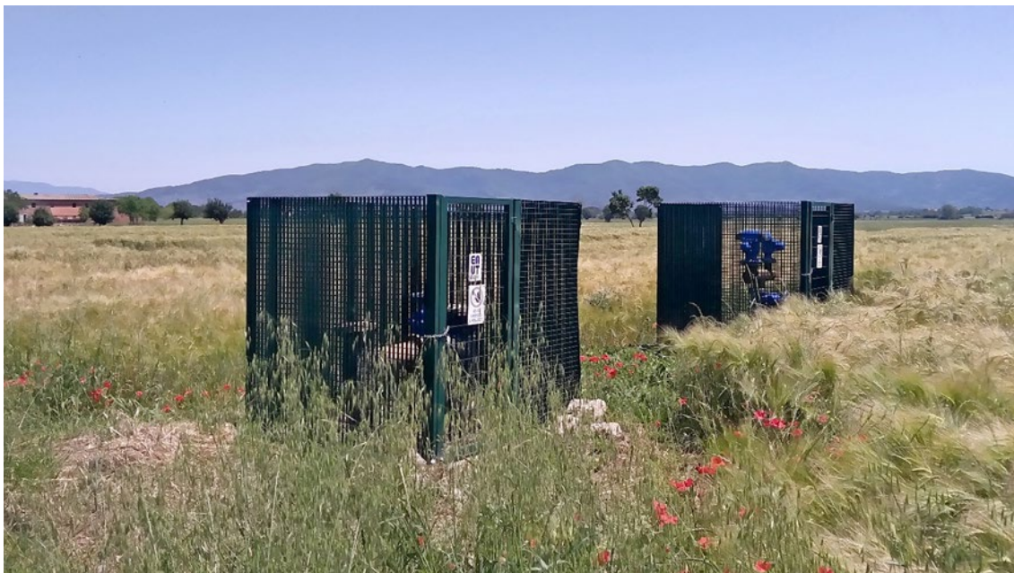
Figura 6 – esempio di manufatti di scarico e sfiato realizzato in precedenti interventi.
