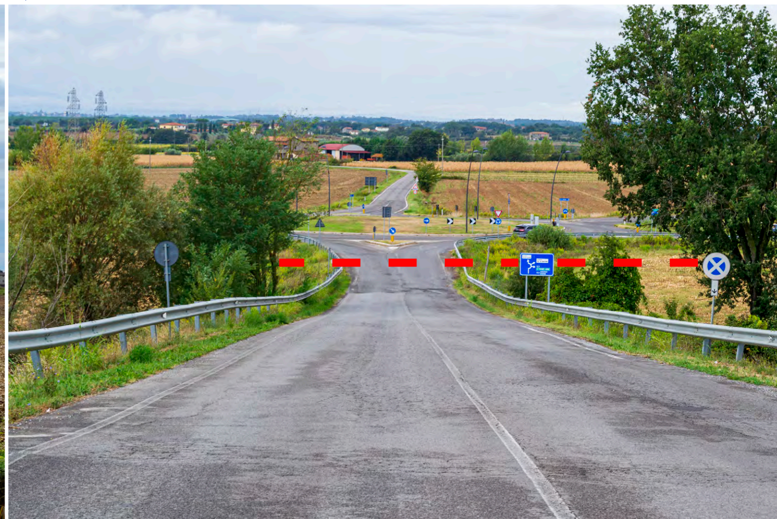
note Punto di attraversamento ai piedi del cavalcavia in località Vallone.
