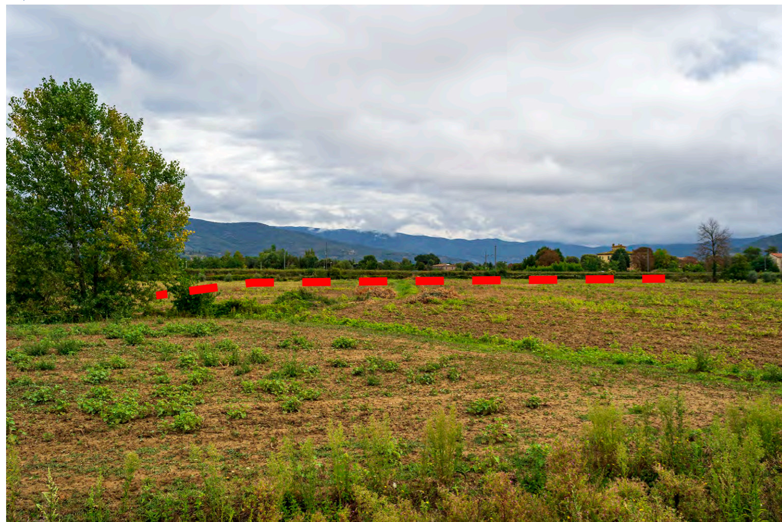
note Vista dell'area di intervento, la diramazione del III Substralcio | I Ramo scorre in parallelo al tracciato esistente lungo la linea ferroviaria Firenze-Roma.
