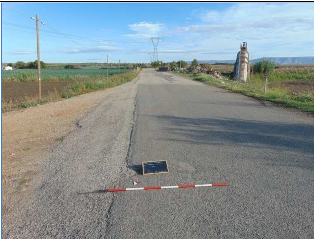
Foto 2: Area del cavidotto dopo il ponte del Canale Santa Maria vista da S
