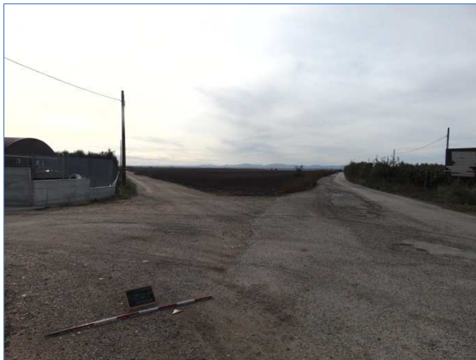
Foto 2: Area della strada interpodereale interessata dal CVD vista da O
