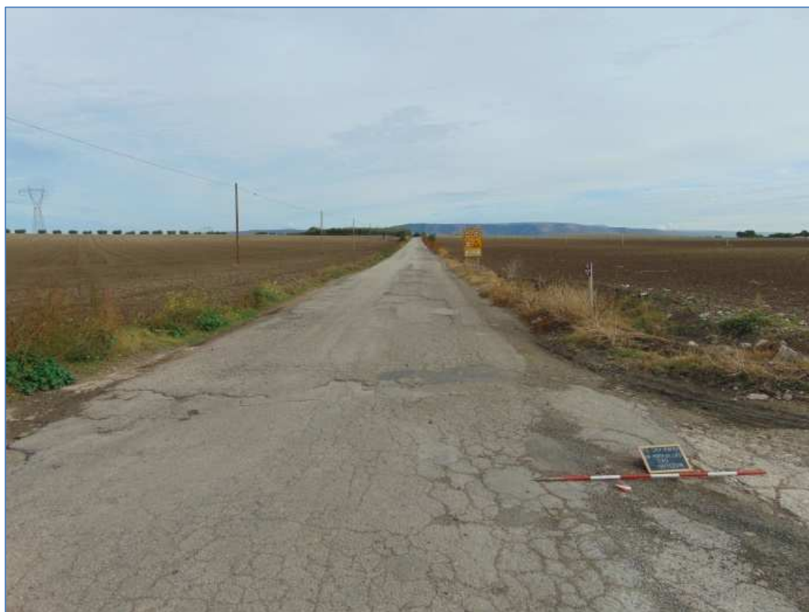
Foto 1: Area del CVD sulla SP 20 vista da N
