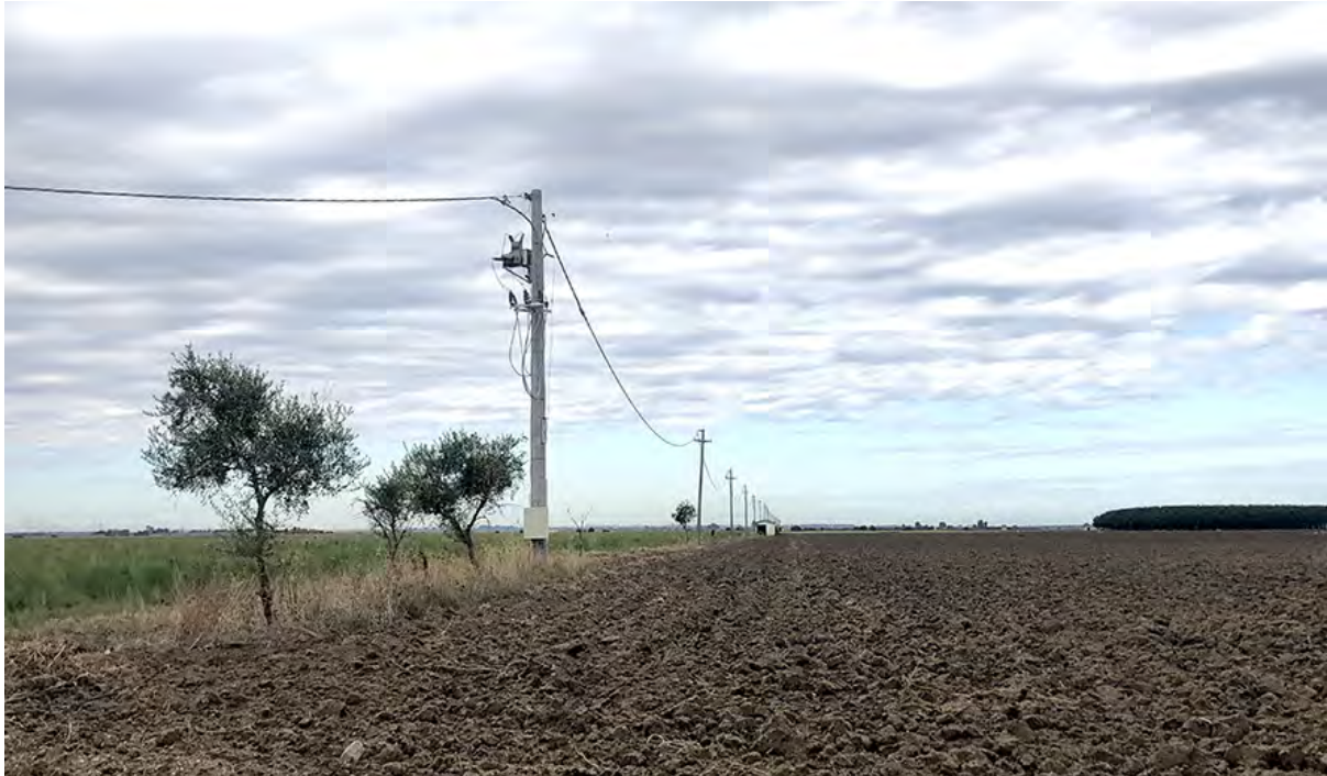
Foto 5 - Area di sedime Torre 12
