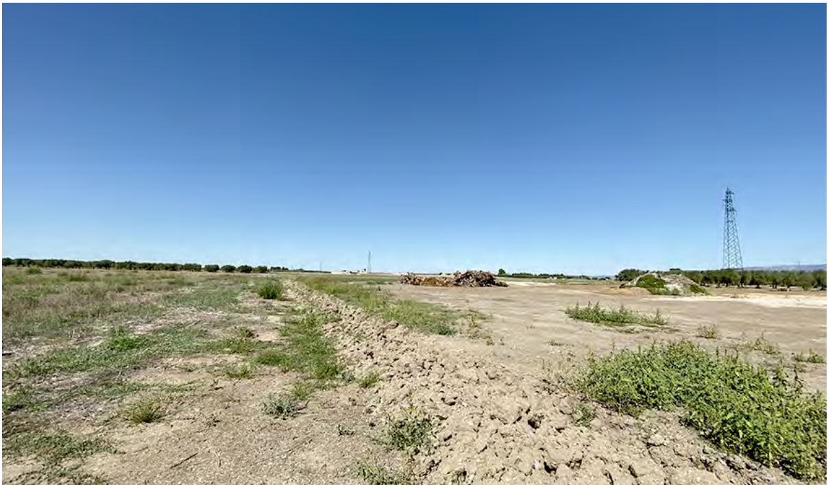
Foto 2 - Area di sedime Torre 4
