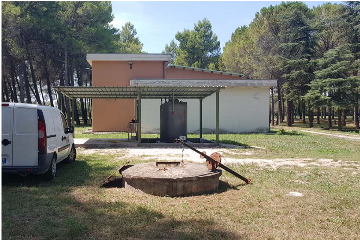
Fig. 2.1/B: vista del Campo pozzi Rotacupa.
