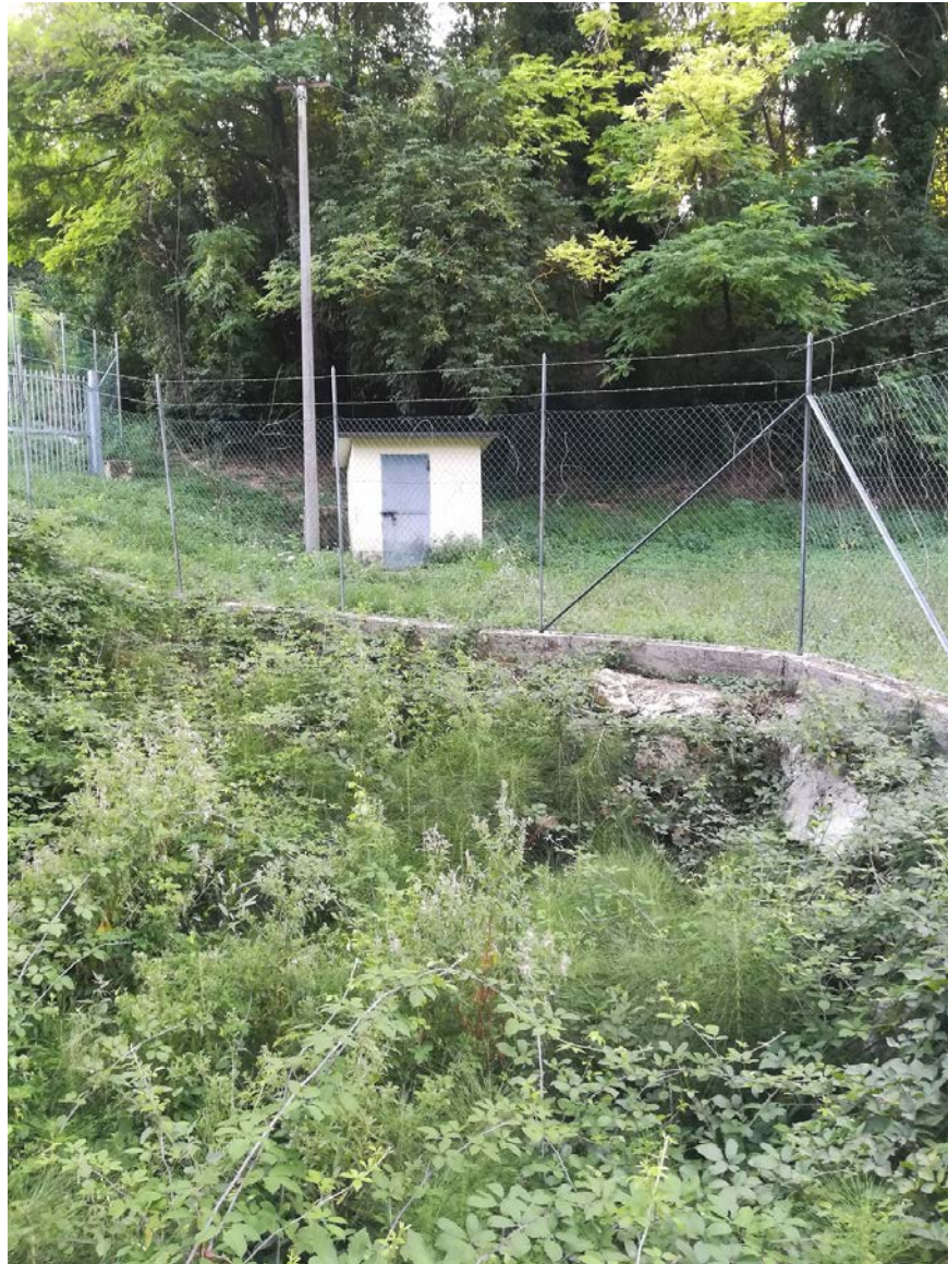
Fig. 2.1/D: Sorgente Fosso di Bagno, opera di captazione.
