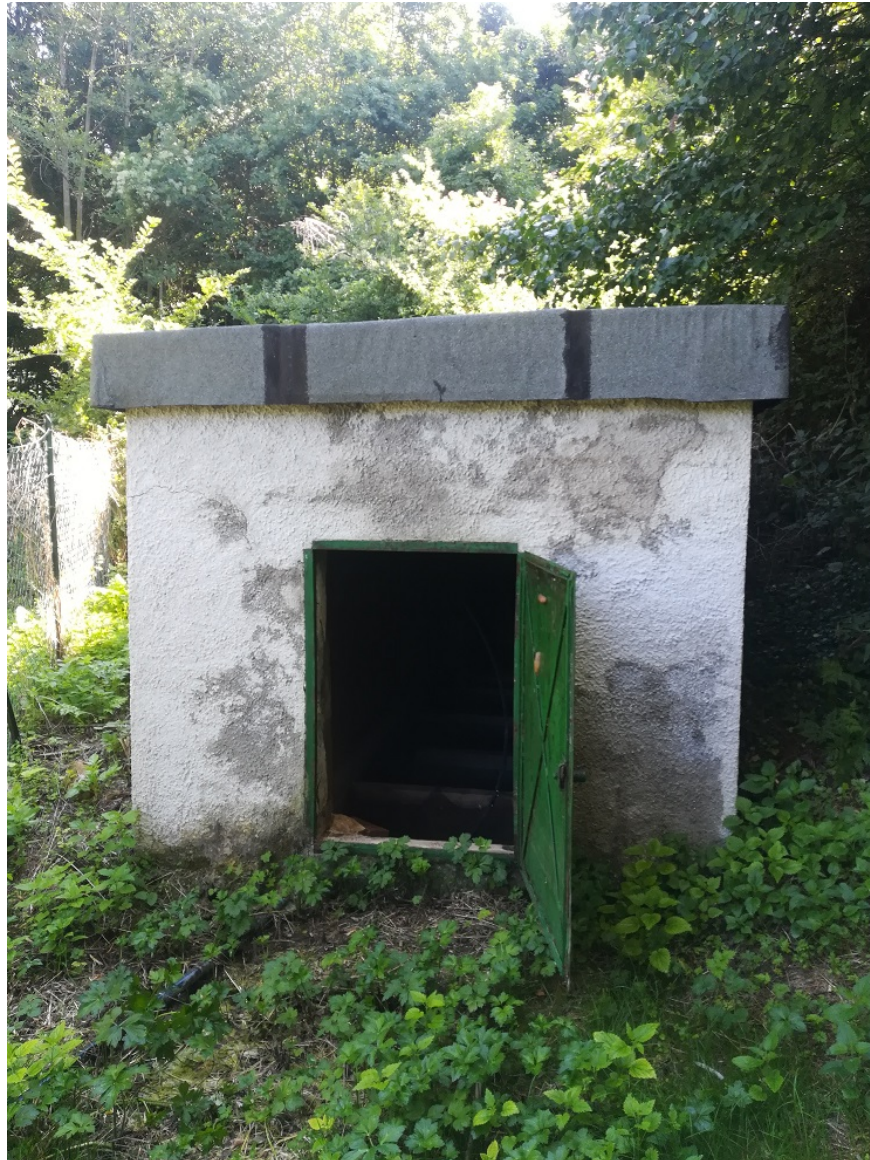
Fig. 2.1/G: Sorgente Fonte Vecchia, opera di captazione.
