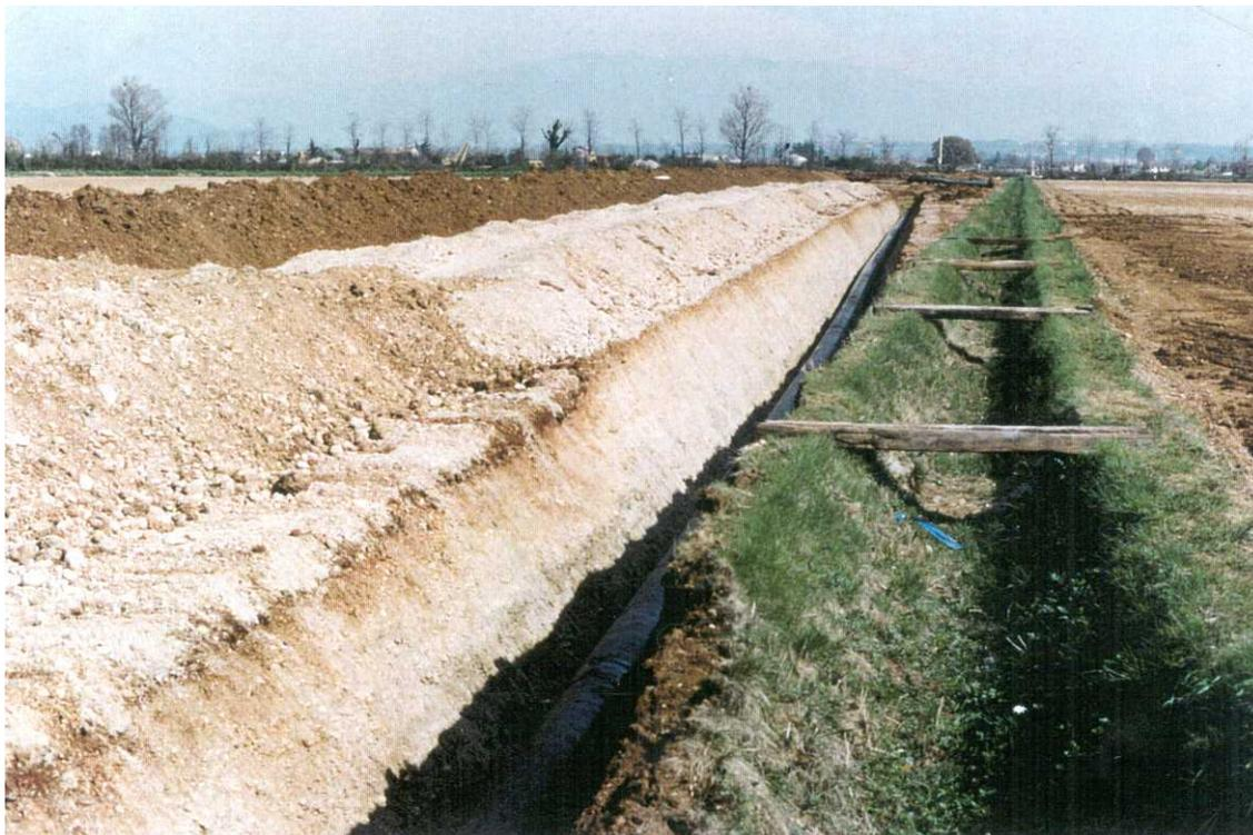
**Foto 10.1/G:Tratto di condotta posata, si nota l'accantonamento dello strato humico separato dal materiale di scavo della trincea**
