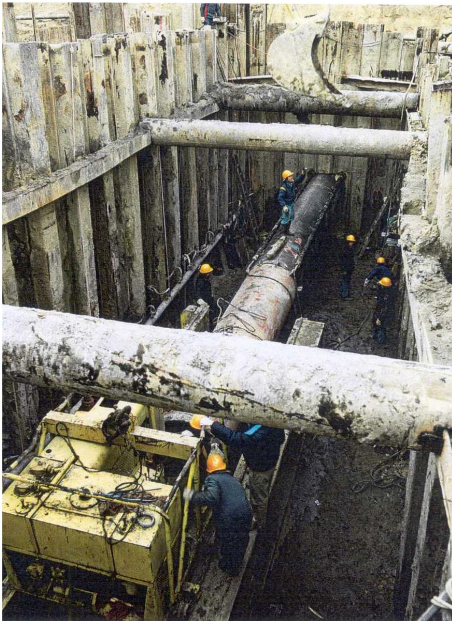
**Foto 10.1/L: Trivellazione con spingitubo**
