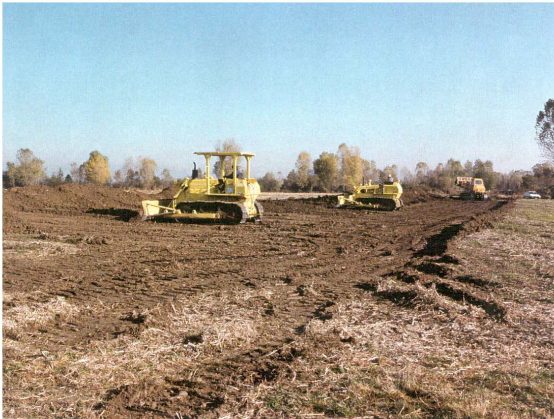
Foto 2.C: Esempio di apertura dell'area di passaggio
