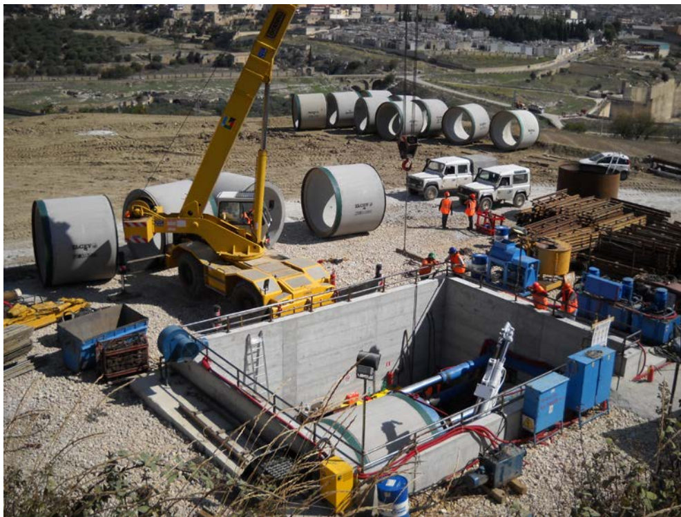
Foto. 2.E: esempio di una postazione di spinta di un Microtunnel
