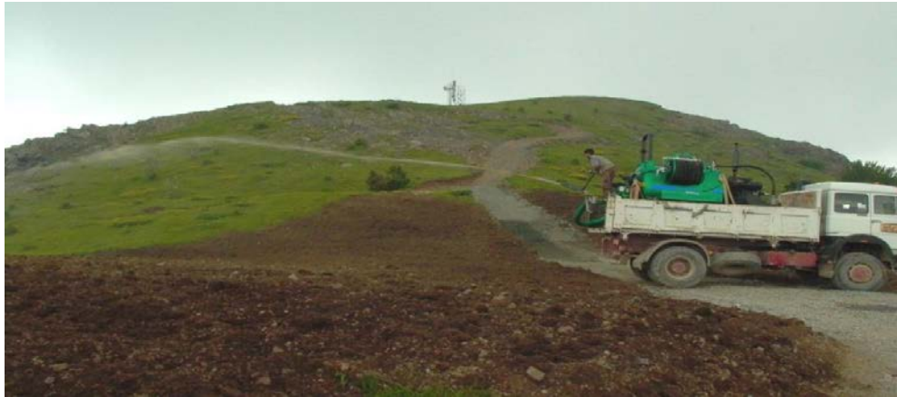
Foto 2.J: Esempio di redistribuzione dello strato superficiale di suolo ( topsoil ) e idrosemina
