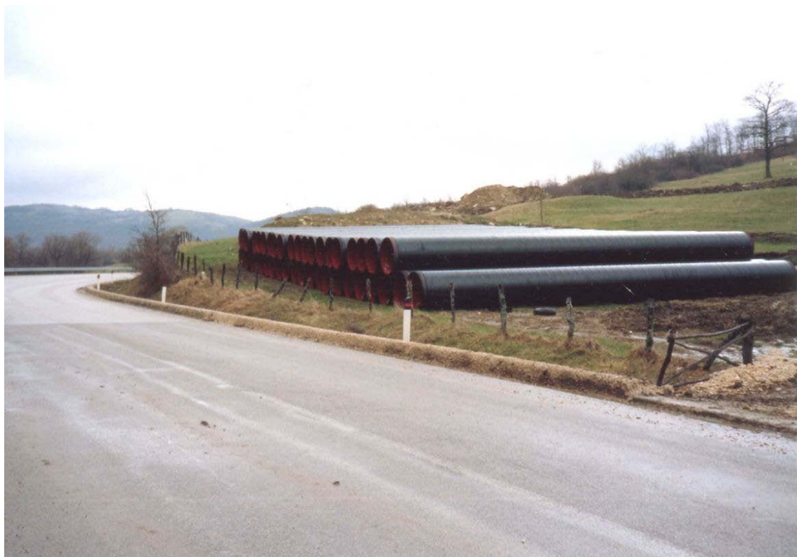
Foto 2.B: Esempio di piazzola di accatastamento tubazioni
