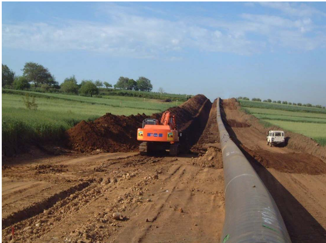
Foto 2.F: Esempio di scavo in trincea
