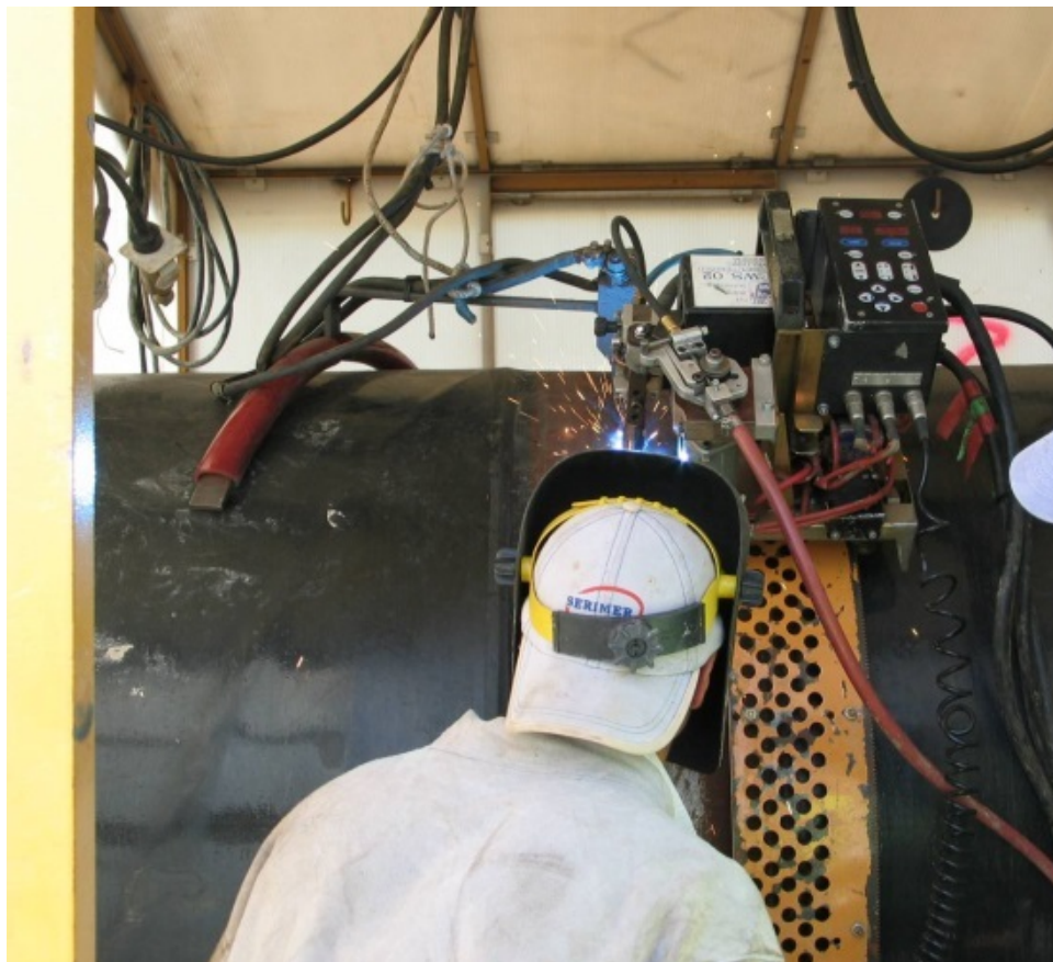
Foto 2.E: Esempio di saldatura di linea
