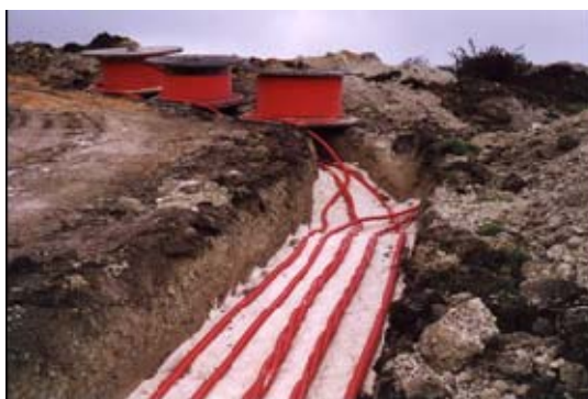
Figura 1 – Posa dei cavidotti interrati
