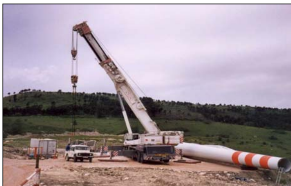
Figura 2 – autogru di montaggio
