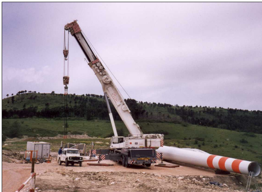
Figura 1.6.6.-1.: Fase di montaggio di un aerogeneratore.
