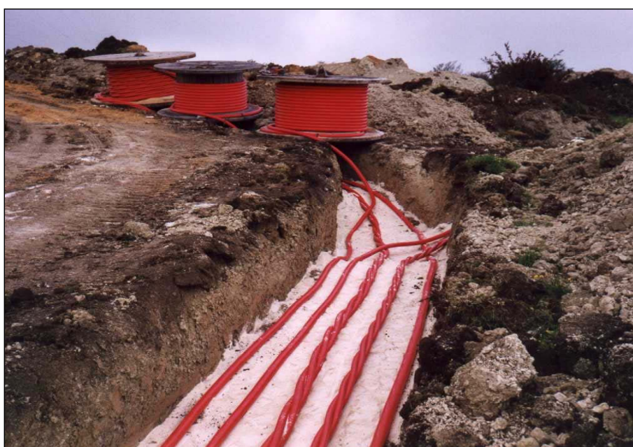
Figura 1.6.7.-1.: Particolare della posa cavi elettrici.
