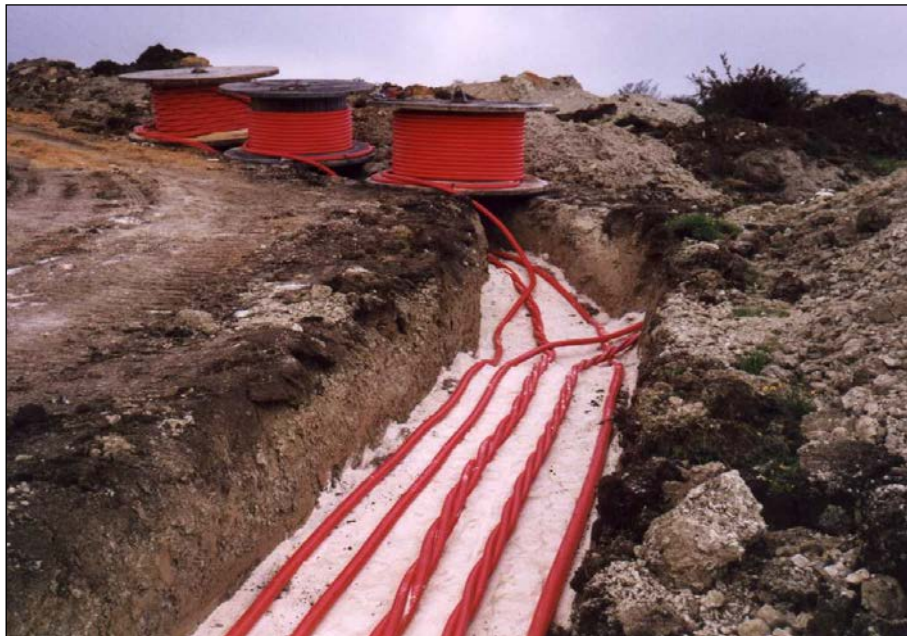
Figura 1.4.7.-1.: Particolare della posa cavi elettrici.
