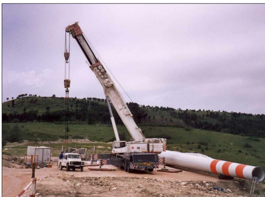
Figura 1.4.6.-1.: Fase di montaggio di un aerogeneratore.
