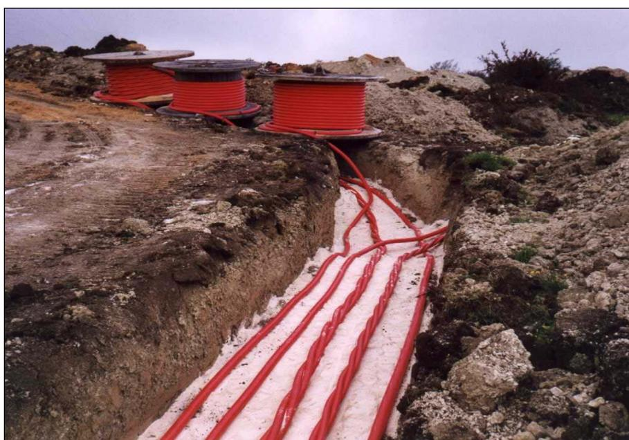
**Figura 1.4.7.-1.: Particolare della posa cavi elettrici.**
