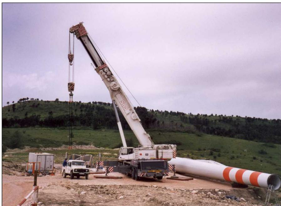
**Figura 1.4.6.-1.: Fase di montaggio di un aerogeneratore.**
