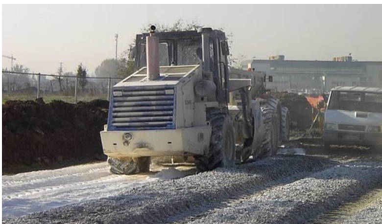
FIGURA 4-41 – STABILIZZAZIONE DELLE TERRE – MISCELAZIONE MEDIANTE PULVIMIXER.
