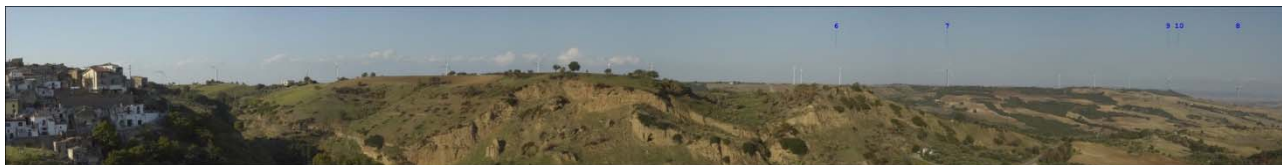
Figura 25 - Stato dei luoghi post operam
