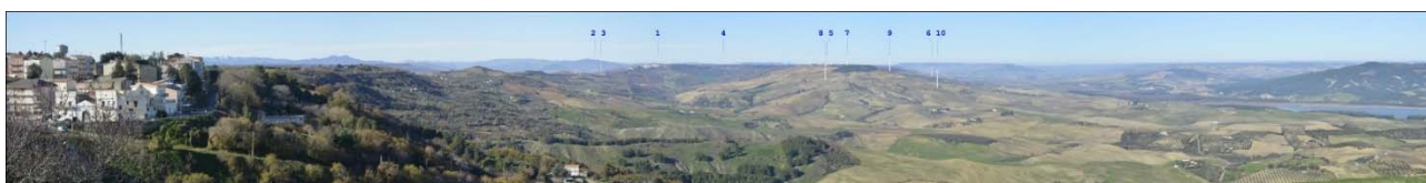
Figura 21: Stato dei luoghi post operam
