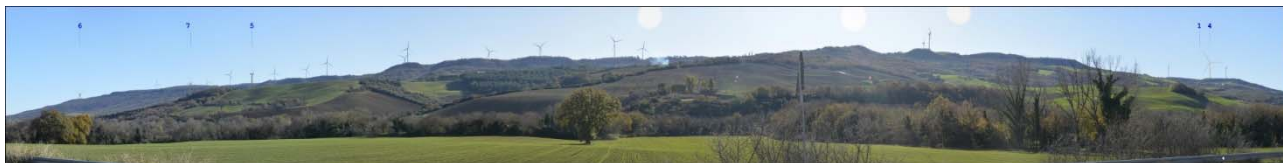
Figura 20: Stato dei luoghi post operam
