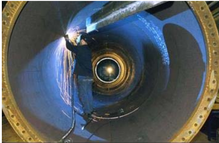
Figura 10: interno di una torre
