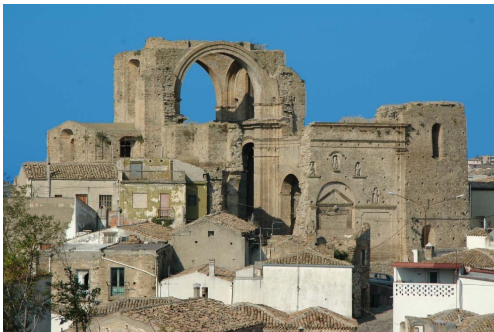
Figura 20: Vista della chiesa "Diruta" (Fonte: Basilicata turistica)
