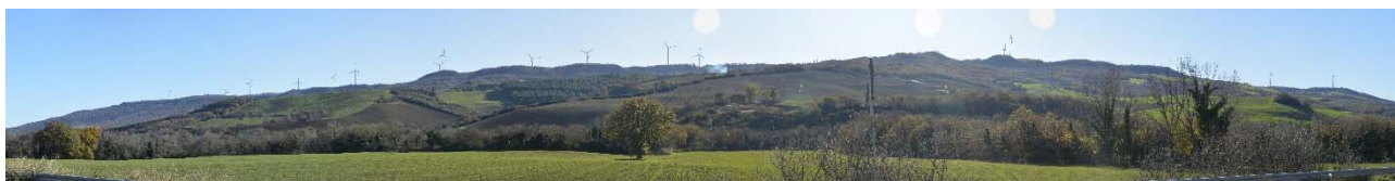
Figura 36: Stato dei luoghi in corrispondenza del punto di ripresa fotografica A
