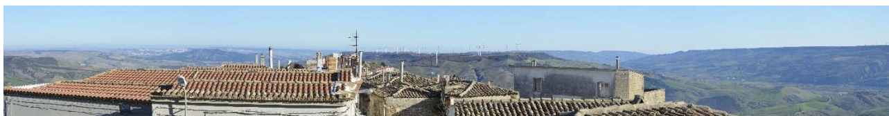
Figura 40: Stato dei luoghi in corrispondenza del punto di ripresa fotografica E
