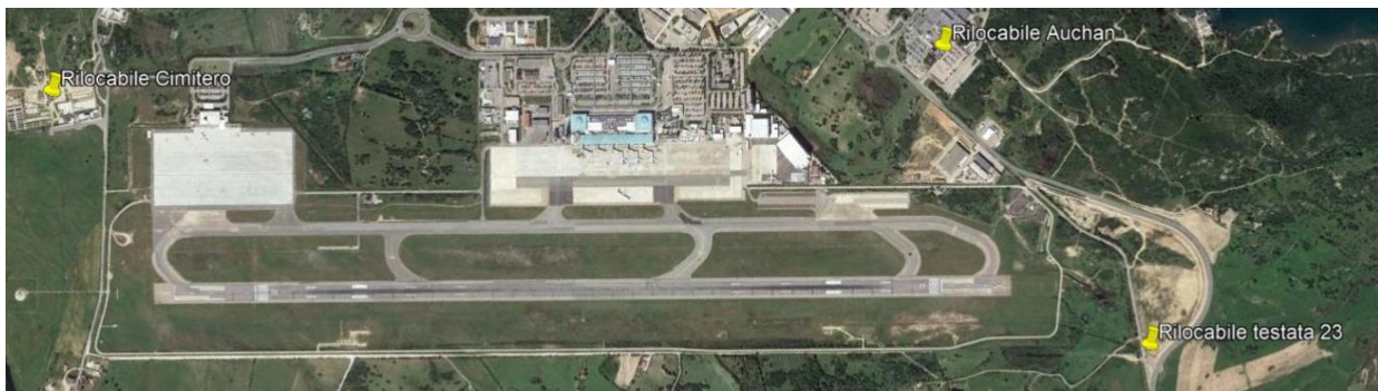
Figura 7: Ubicazione delle centraline
