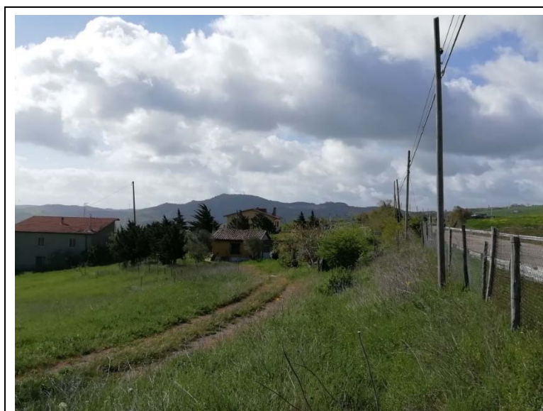
Panoramica dell'edificio e dell'area esterna dal lato del cancello di ingresso
