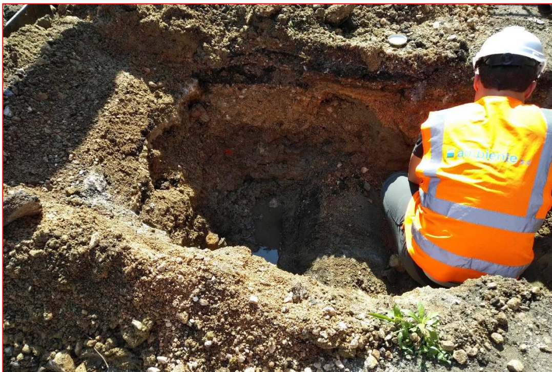
Fig. 4 – Particolare punto SC1: dettaglio stratigrafico, materiale campionato, pareti e fondo scavo
