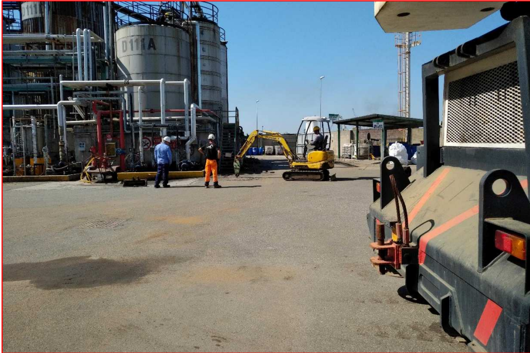
Fig. 5 – Scavo punto campionamento SC2
