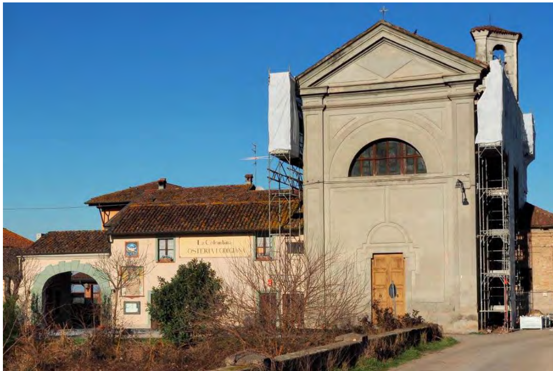
Figura 22: L'attuale facciata dell'oratorio di Sant'Antonio Abate adiacente alla storica Osteria.
