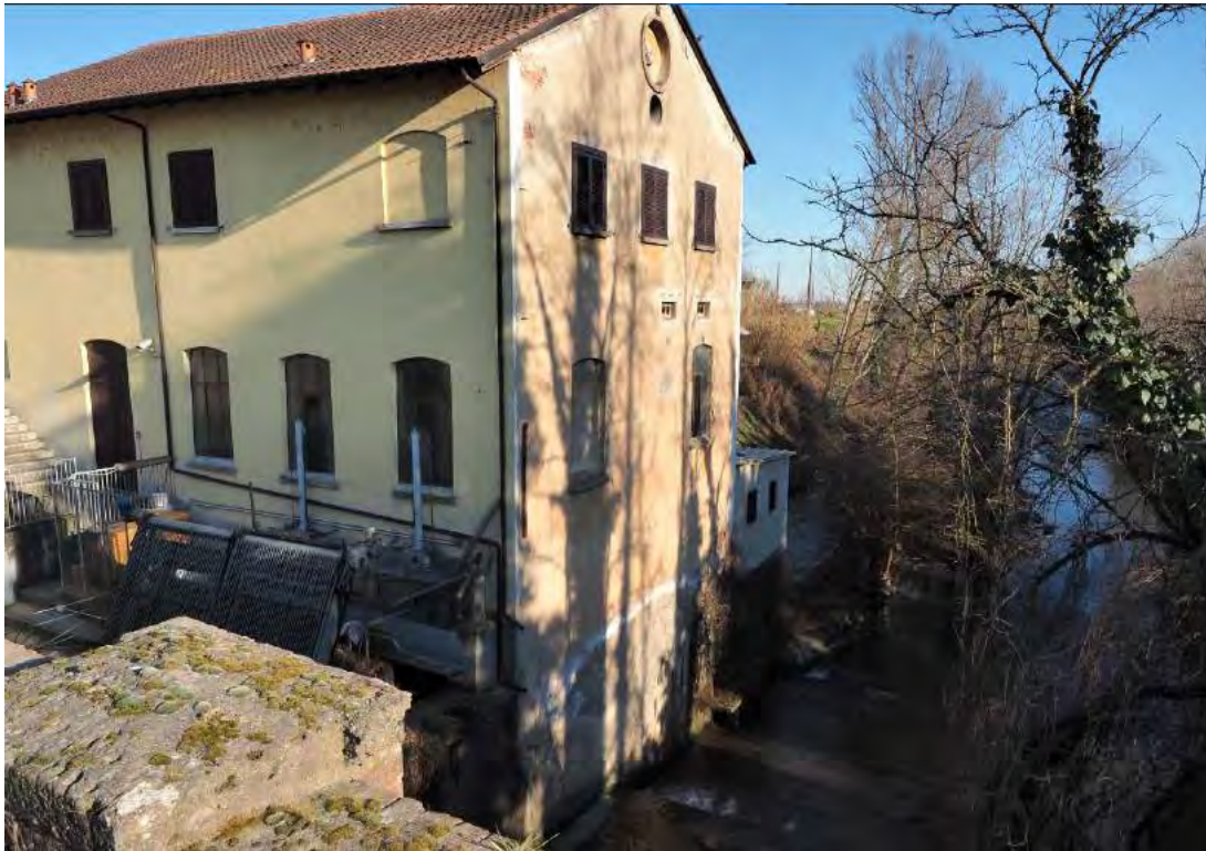
Figura 4: Centrale idroelettrica Colombina (Bertonico)
