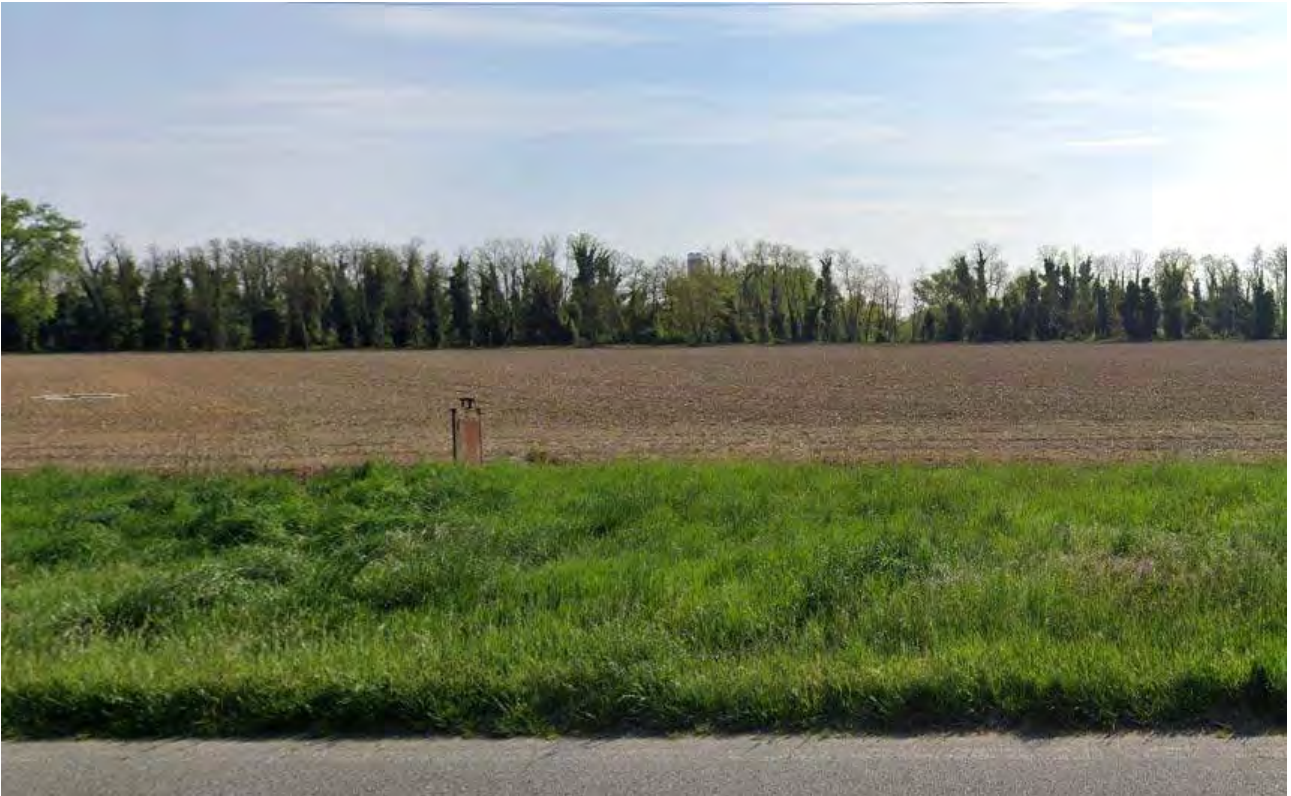
Figura 7: vista dalla S.P. 26, a N dell'area di progetto, della fascia boscata lungo il Colatore Muzza, significativa quinta visiva rispetto al comparto industriale in esame; si intravede al centro il camino della CTE Sorgenia Power esistente, alto 100 m.
