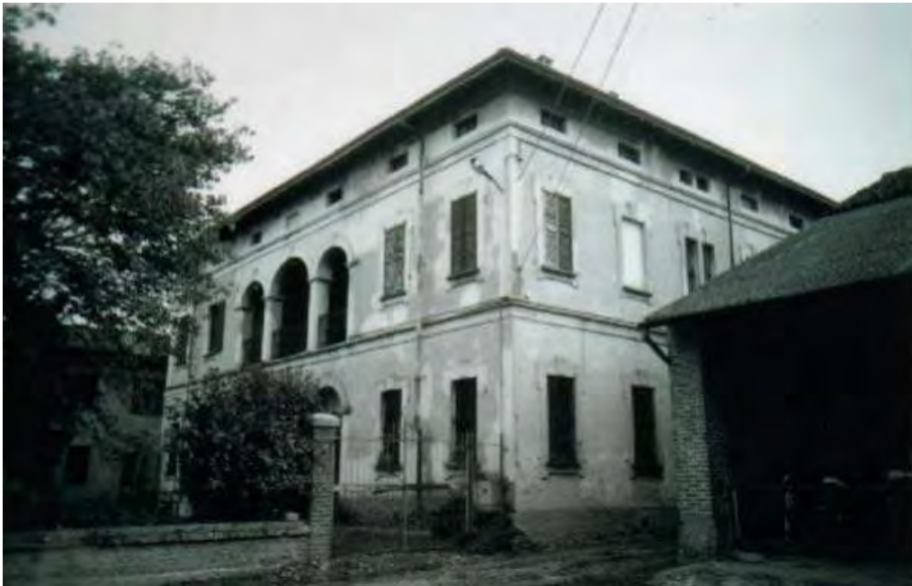
Figura 50: Foto storica della casa padronale di cascina Grande (da scheda SIRBeC).
