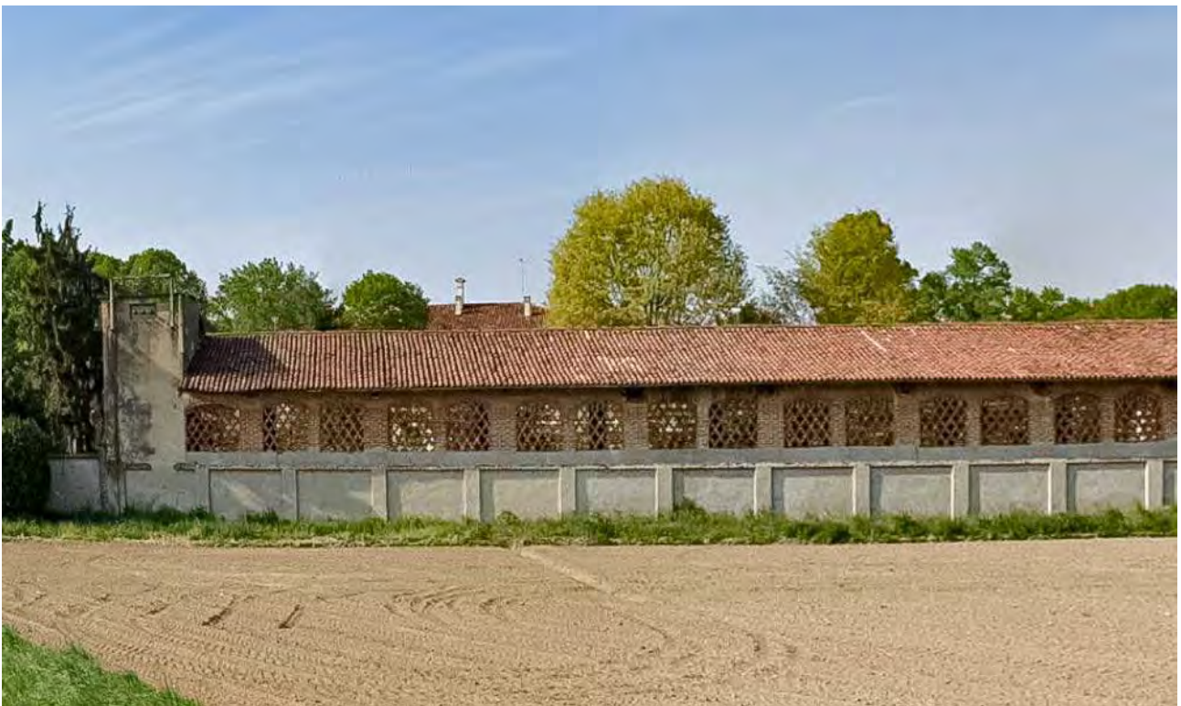
Figura 29: Vista dalla SP 26 delle stalle sul lato S
