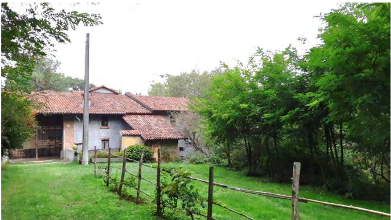
Figura 35: Stato attuale del complesso.
