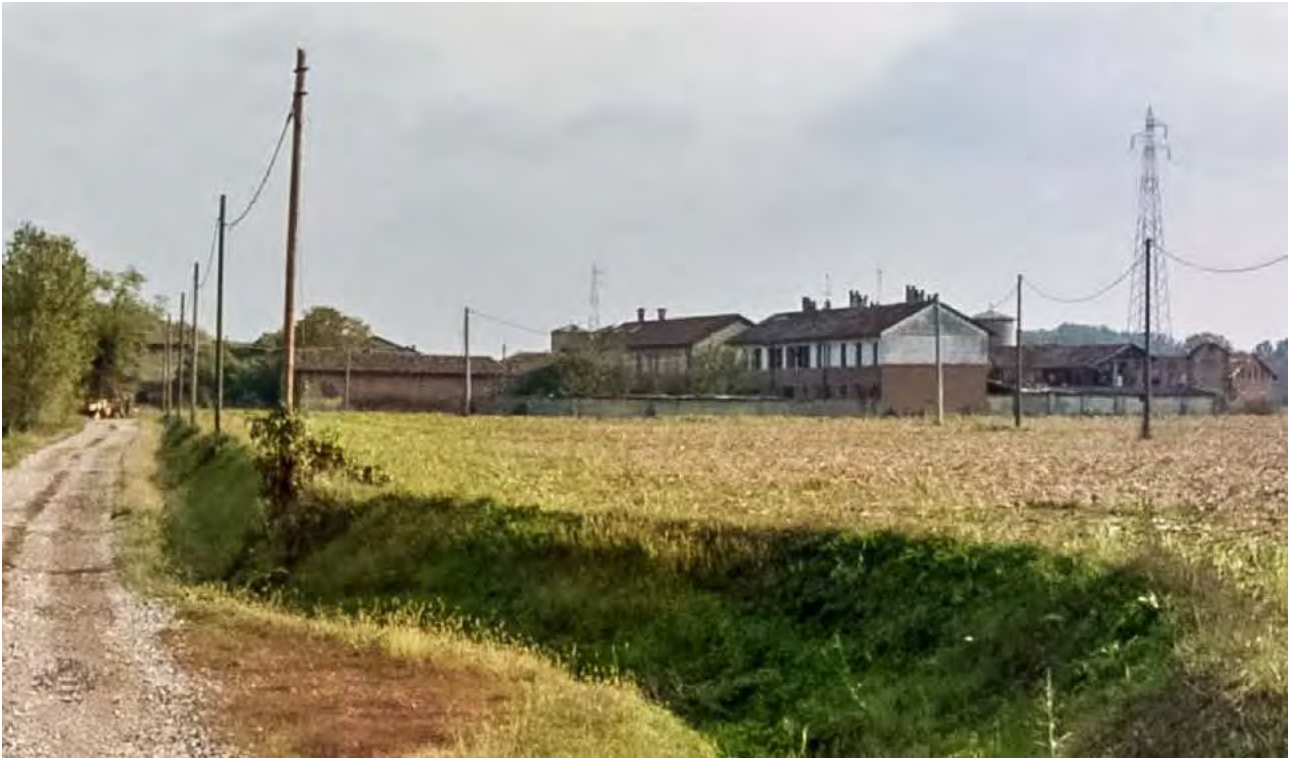
Figura 24: Stato attuale del complesso
