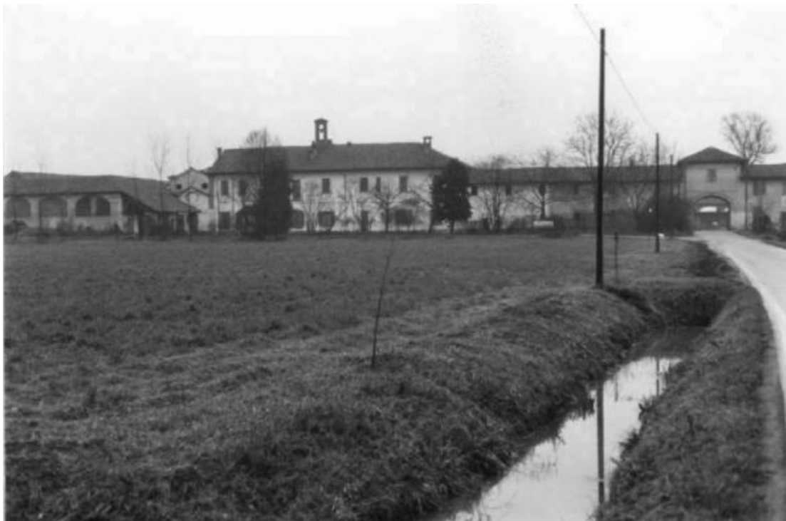
Figura 55: Foto storica del complesso (da scheda SIRBeC).
