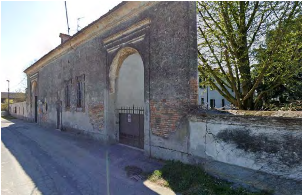
Figura 47: Casa di via Piave 2.
