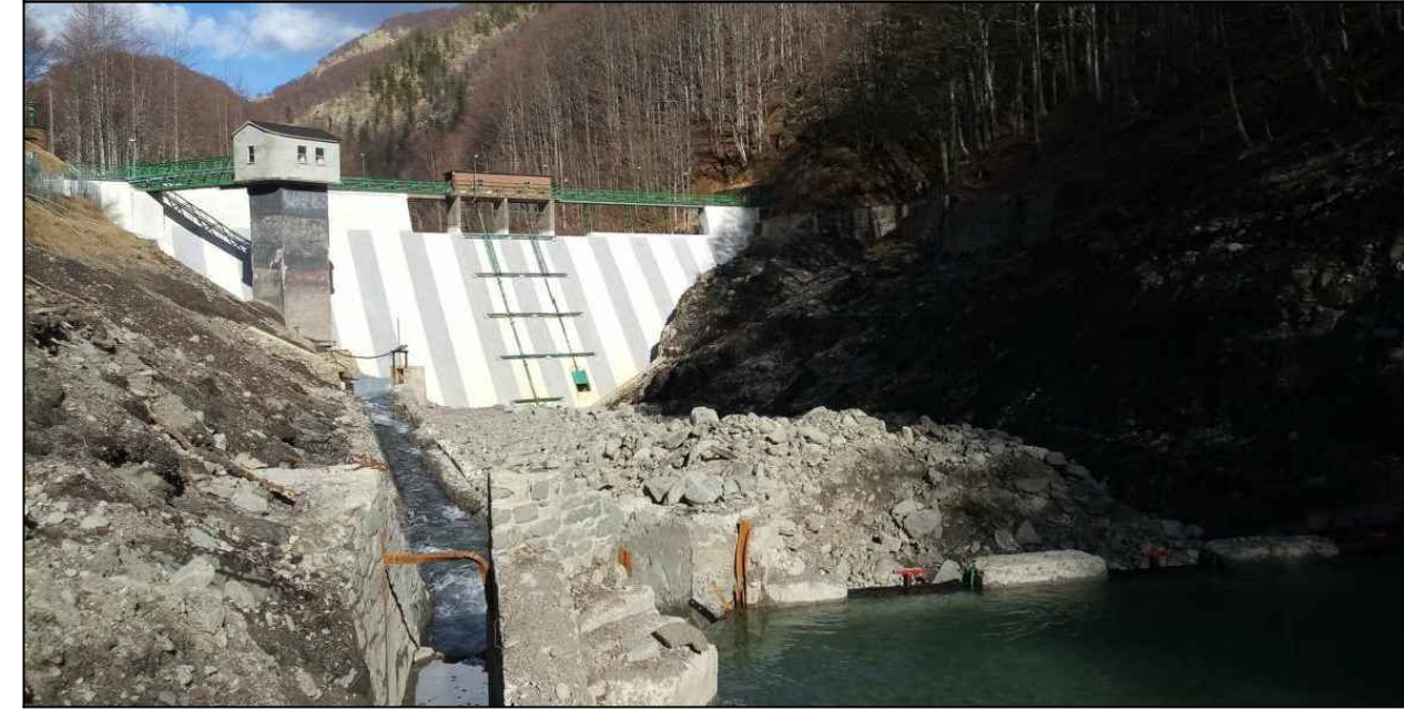
Punto di scatto 3 - Diga vista da monte
