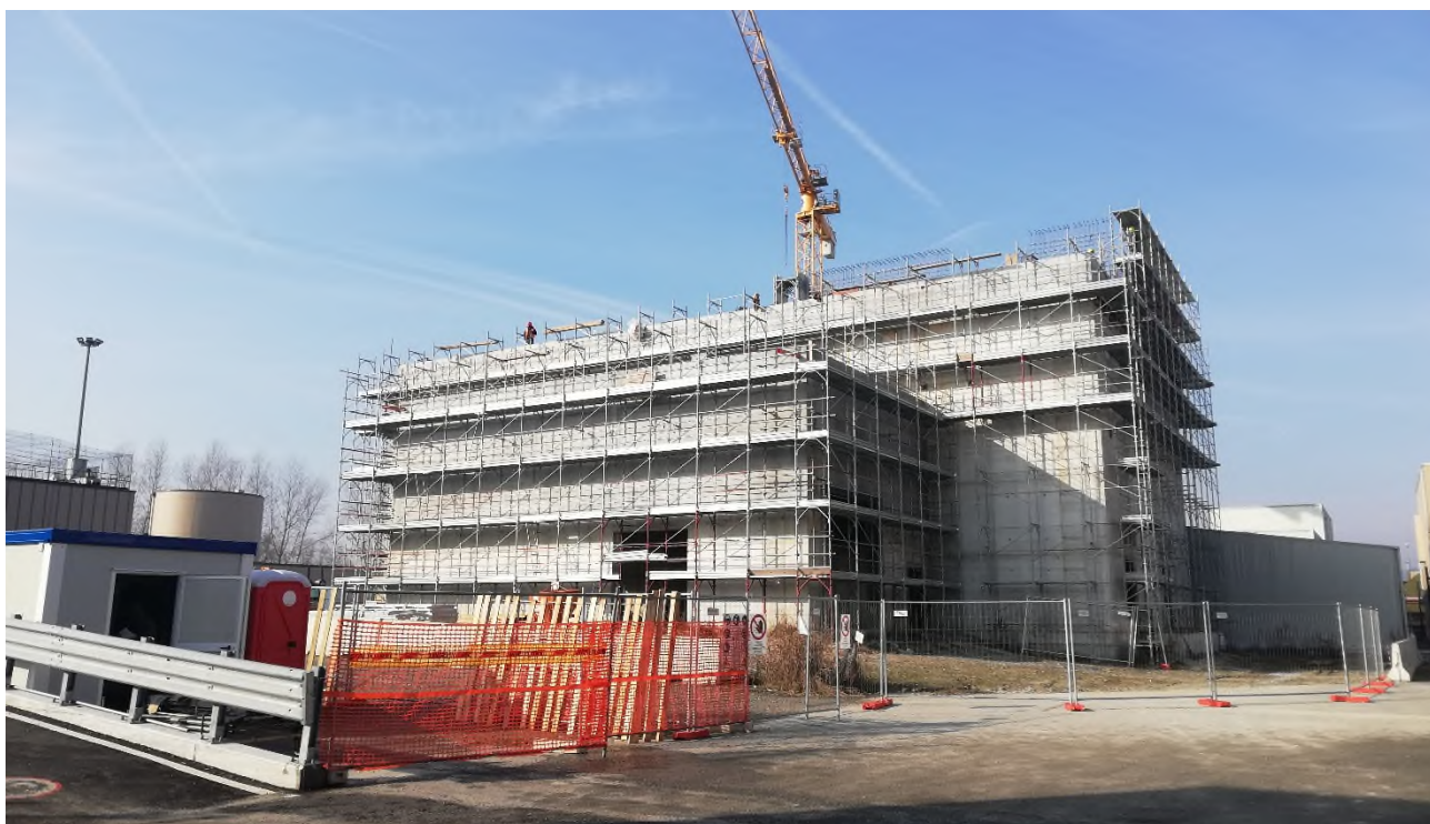
Figura 2-6 - layout di cantiere a gennaio 2020 lato SE
