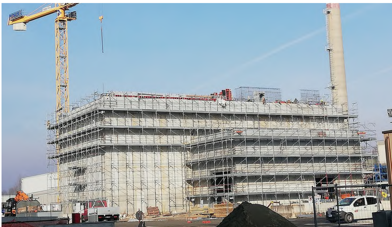
Figura 2-5 - layout di cantiere a gennaio 2020 lato SSE
