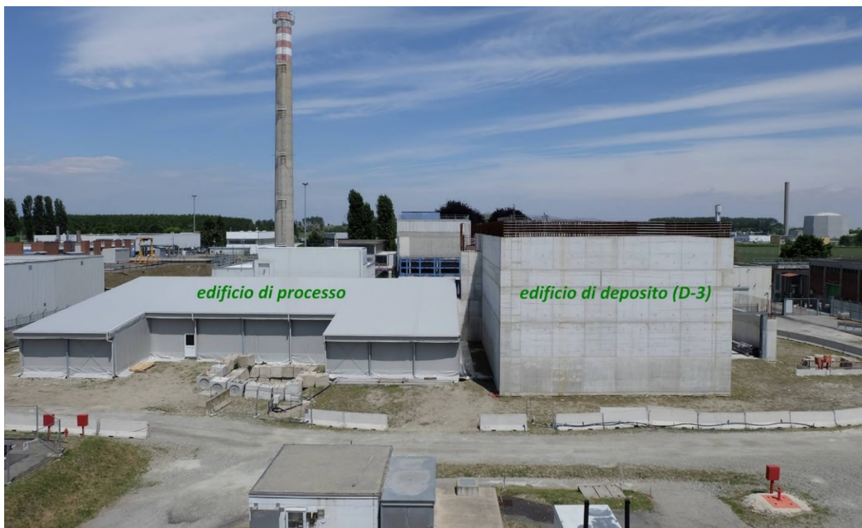
Figura 2-2 - copertura edificio di processo Cemex sulla sinistra – maggio 2019
