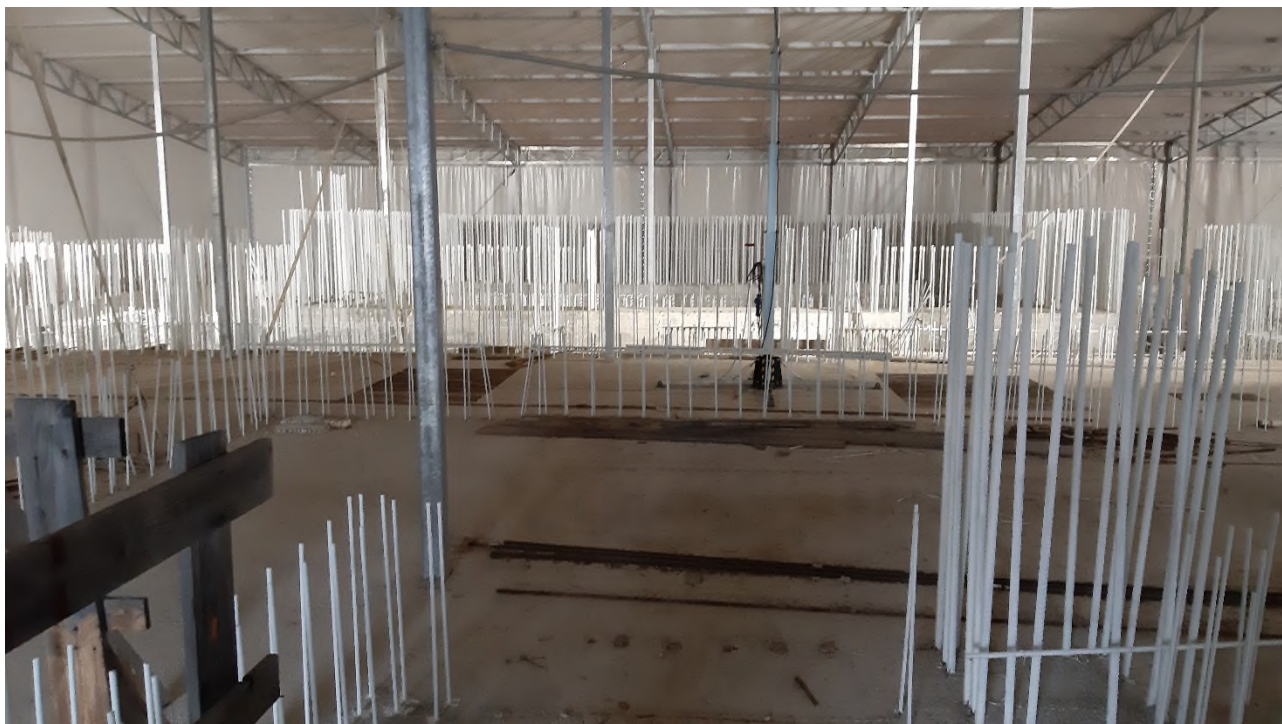
Figura 2-1 – copertura dell'edificio di processo: interno e solaio a quota +0,00 m e ferri sottoposti a trattamento protettivo – maggio 2019
