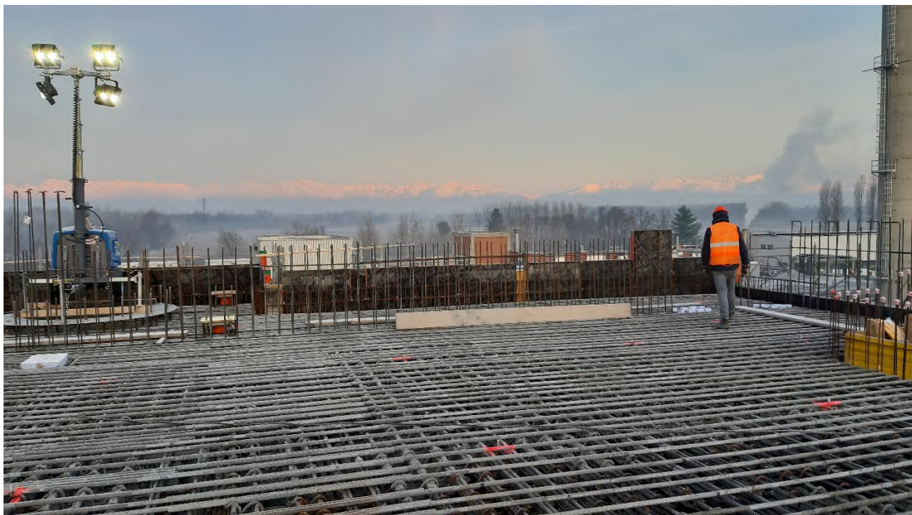
Figura 2-4 – ultima fase del getto del solaio S6 – dicembre 2019
