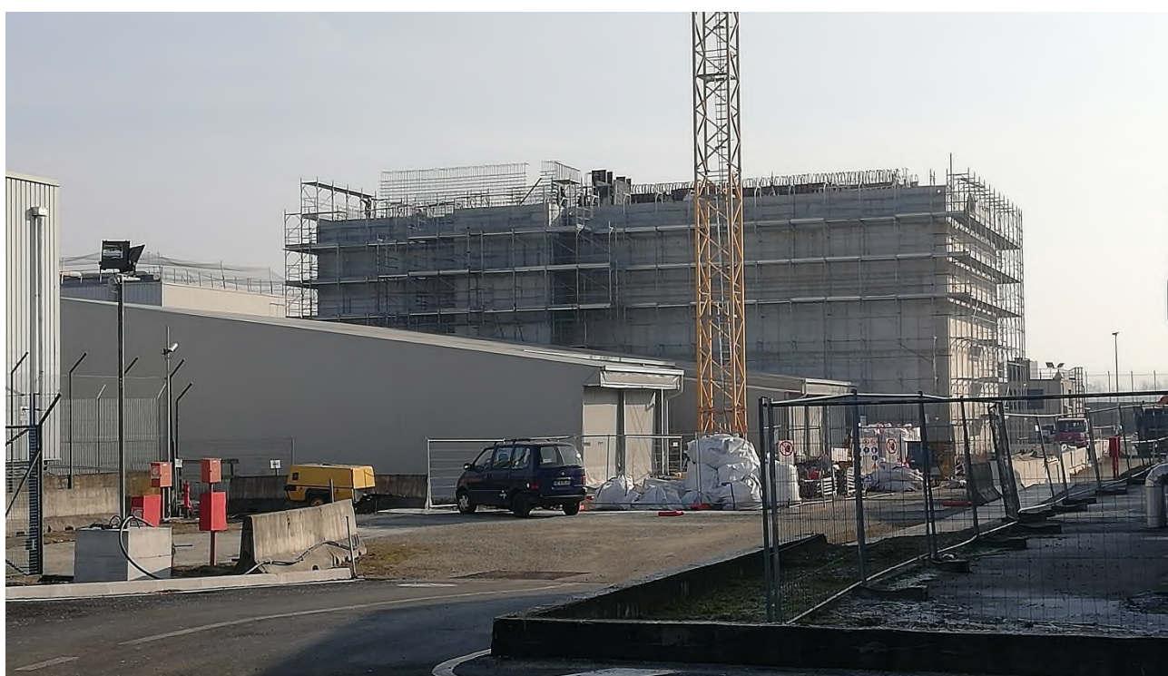
Figura 2-7 - layout di cantiere a gennaio 2020 lato NNO
