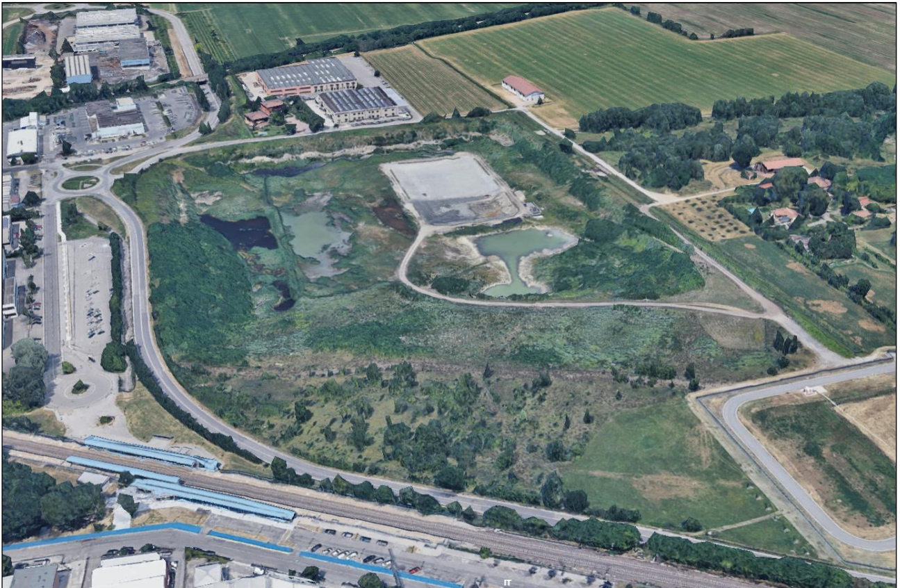
Figura 1 – Vista d'insieme dell'area di Cava Olmi
