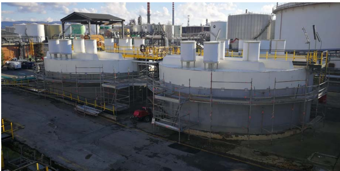
Figura 4 – Vista laterale delle coperture dei due ispessitori
