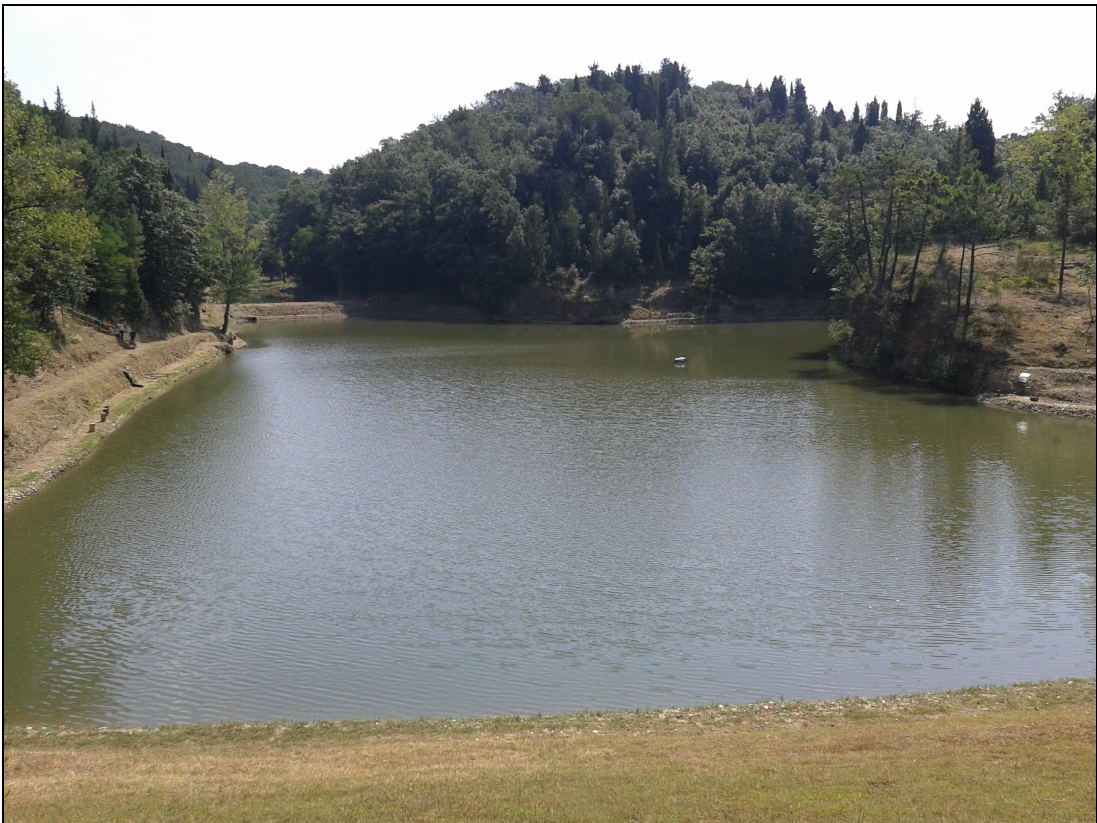
Figura A-4 – Vista dal coronamento verso valle.
