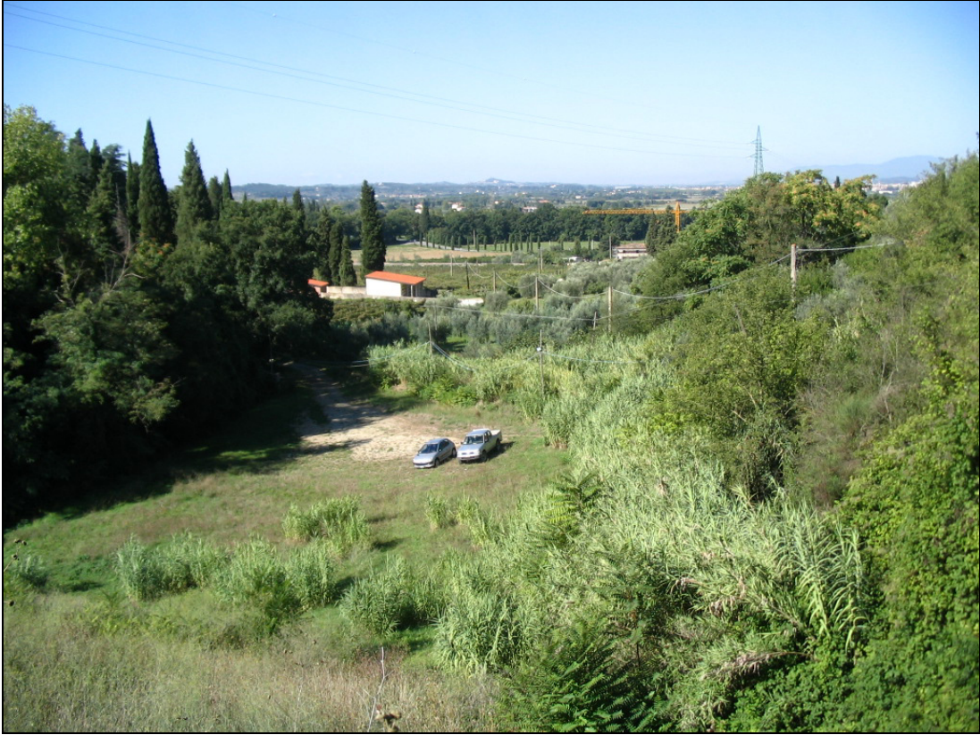
Figura A-3 – Vista dal coronamento verso valle.
