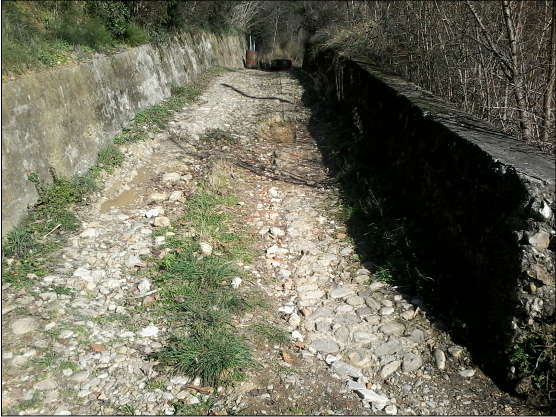
Figura A-7 – Canale fugatore (vista valle- monte).
