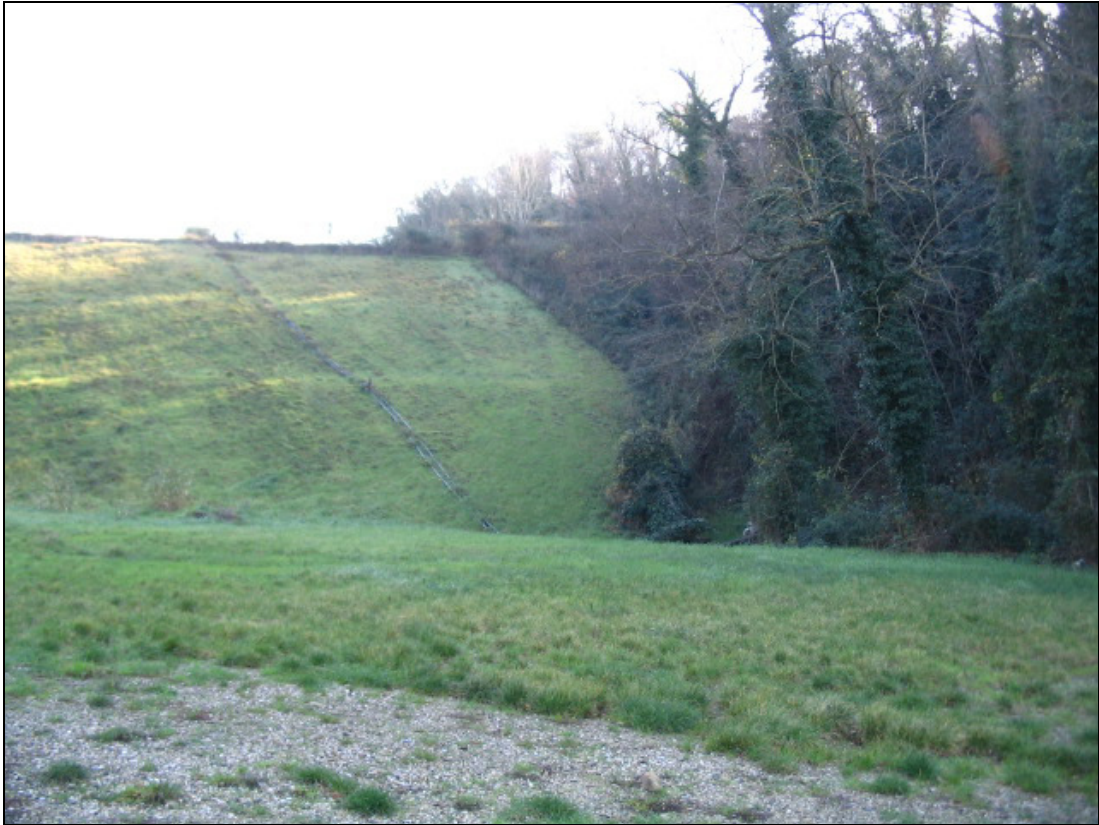
Figura A-13 – Sifoni sul paramento di valle.
