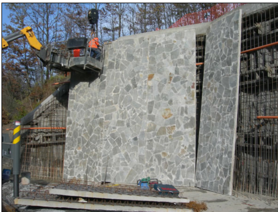
Figura 4-1 - Tipologia del rivestimento dei muri in sponda destra e sinistra
