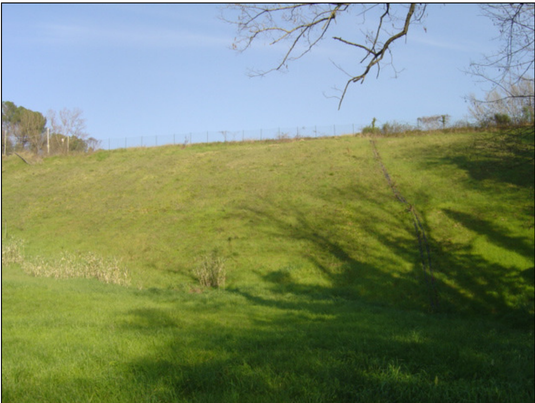
Figura A-2 – Vista del paramento di valle.
