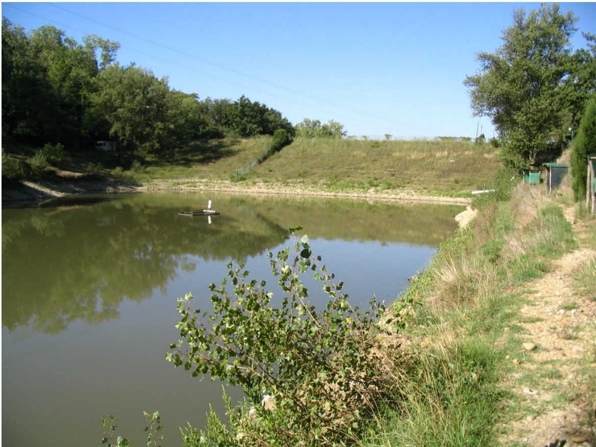
Figura 25 -Vista del paramento di monte
