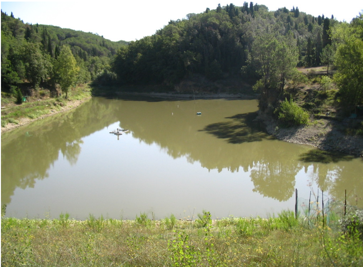
Figura 27 - Vista del lago dal coronamento
