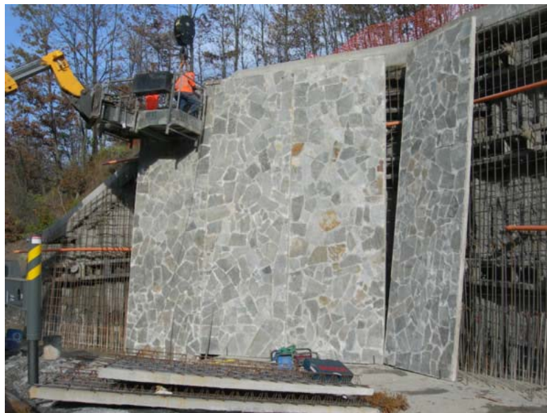
Figura 30 – Tipologia del rivestimento dei muri in sponda destra e sinistra
