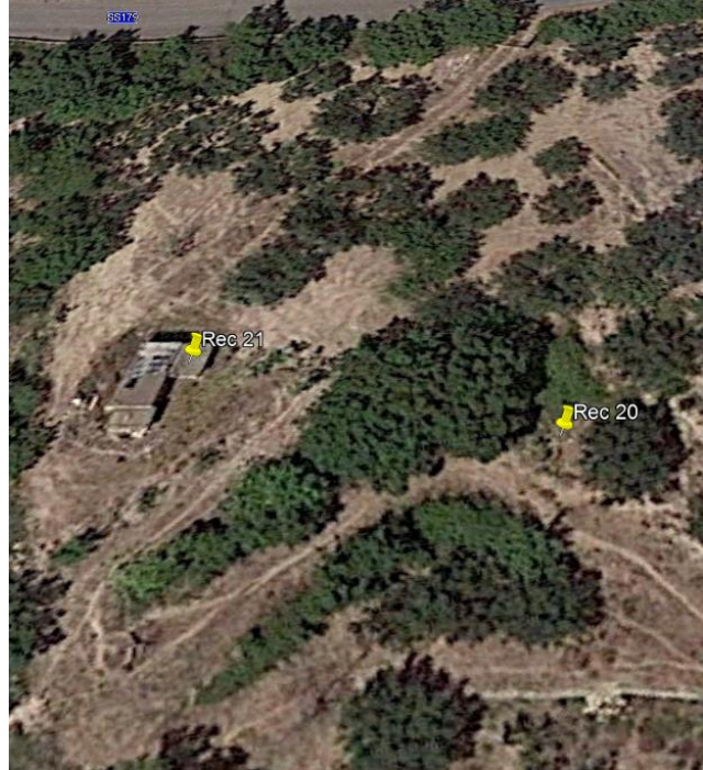
Sito non accessibile e struttura non fotografabile a distanza
