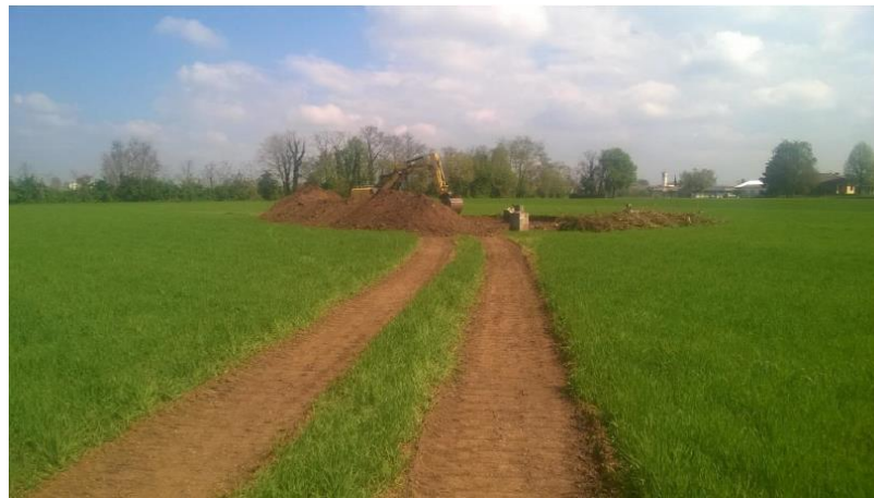
Figura 3-20 Esempio di pista btemporanea su terreno agricolo
