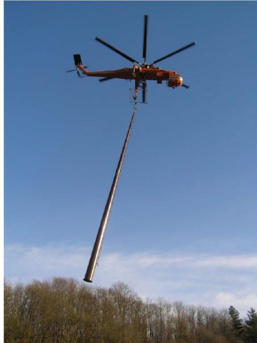
Figura 3-13 Esempio di trasporto di un sostegno con elicottero (tipo Erickson)
