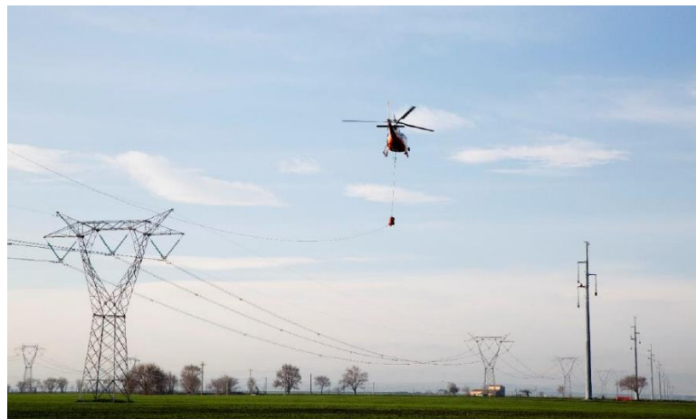
Figura 3-14 utilizzo dell’elicottero per la stesura della fune pilota
