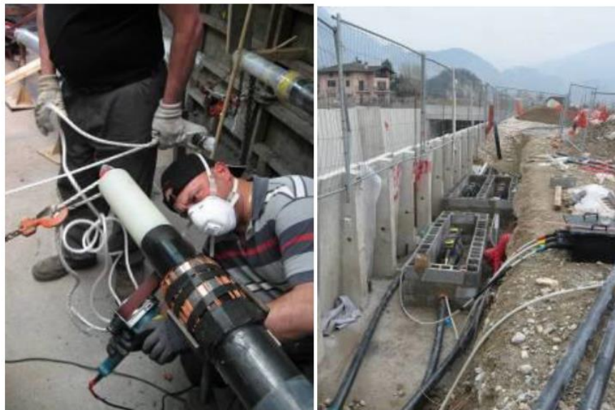
Figura 3-19 Esempio di esecuzione buca giunti
