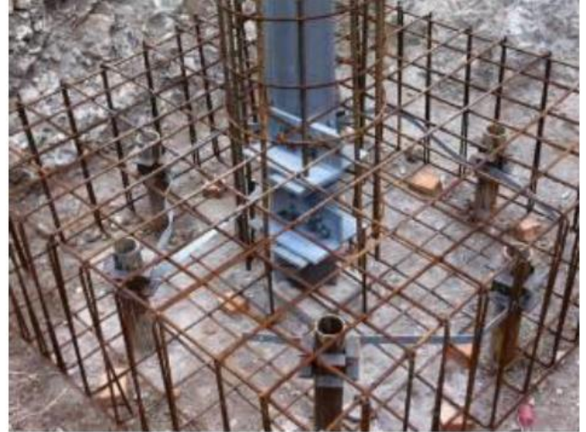
Figura 3-12 Esempio di realizzazione di una fondazione su micropali tipo tubfix
