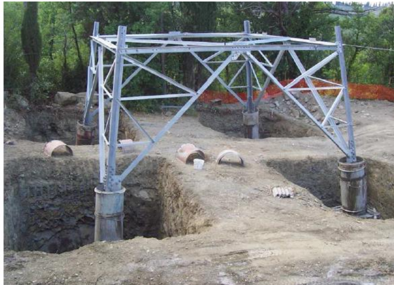
Figura 3-8 Realizzazione di fondazioni superficiali tipo CR per un sostegno a traliccio, con le quattro buche, la base del sostegno collegata alla fondazione tramite monconi ed i casseri utilizzati per i quattro colonnini
