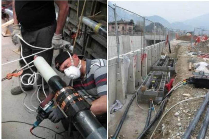
**Figura 2-20 Esempio di esecuzione buca giunti**
