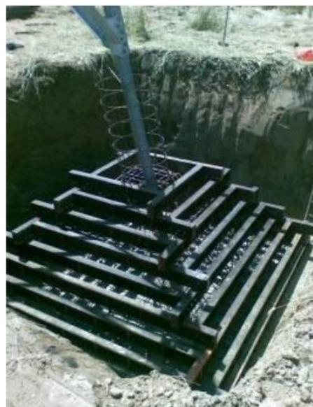
**Figura 2-8 Esempio di realizzazione di una fondazione a plinto con riseghe. Nell'immagine di sinistra di può osservare un disegno di progetto mentre nell'immagine di destra la fase di cassetatura della fondazione**
