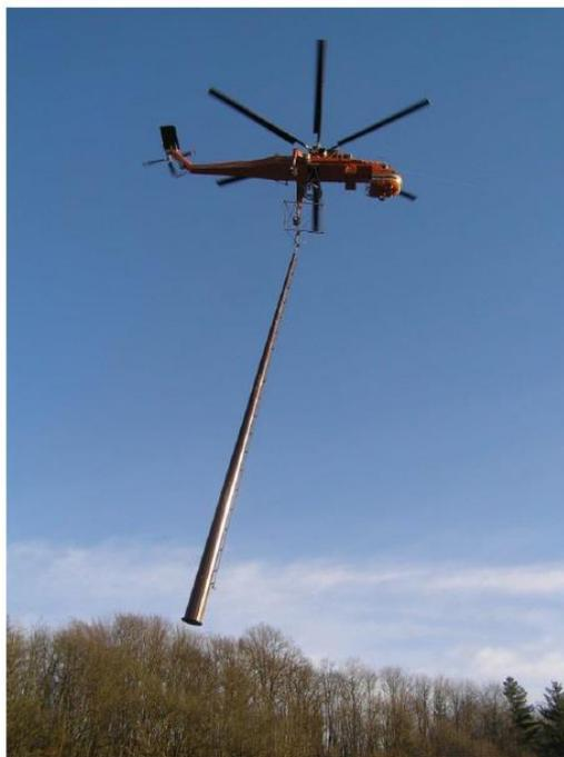
**Figura 2-14 Esempio di trasporto di un sostegno con elicottero (tipo Erickson)**
