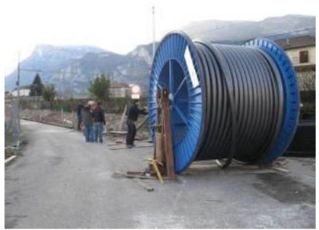
**Figura 2-19 Esempi di posizionamento della bobina contenente il cavo**
