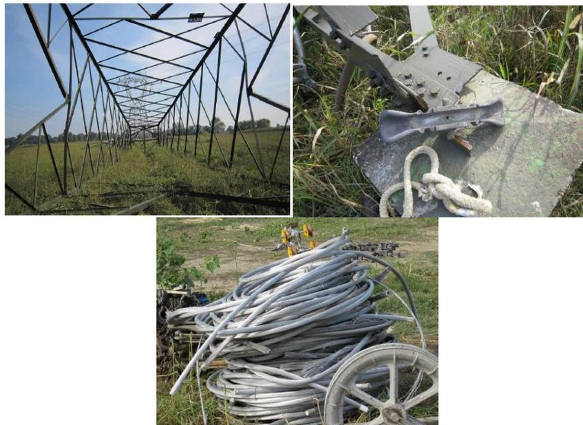
**Figura 2-22 Fasi di demolizione di un sostegno a traliccio**
