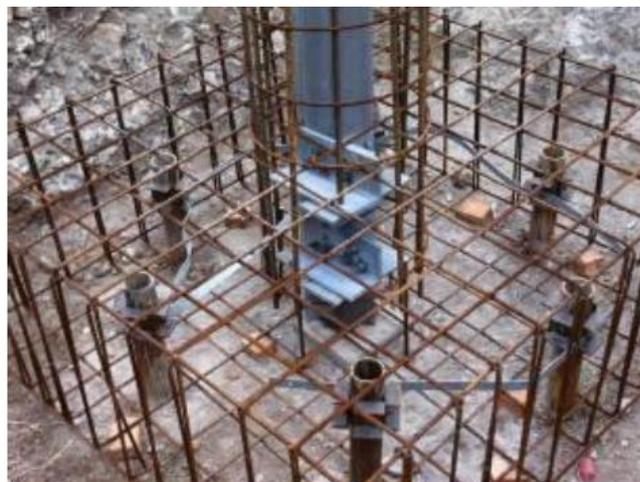
**Figura 2-13 Esempio di realizzazione di una fondazione su micropali tipo tubfix**
