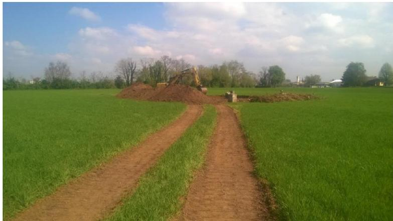
**Figura 2-21 Esempio di pista btemporanea su terreno agricolo**
