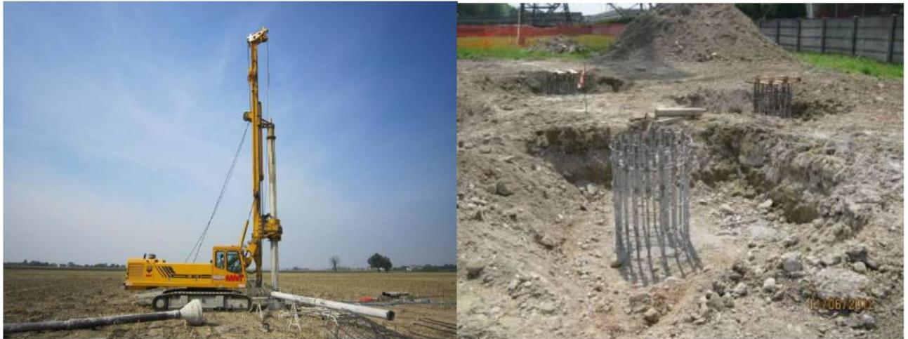
**Figura 2-11 Macchina operatrice per la realizzazione di pali trivellati**
