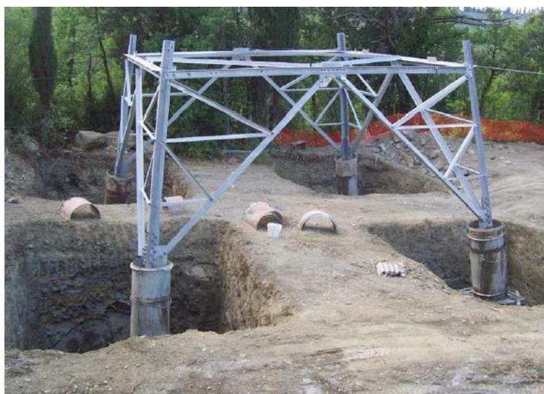
**Figura 2-9 Realizzazione di fondazioni superficiali tipo CR per un sostegno a traliccio, con le quattro buche, la base del sostegno collegata alla fondazione tramite monconi ed i casseri utilizzati per i quattro colonnini**
