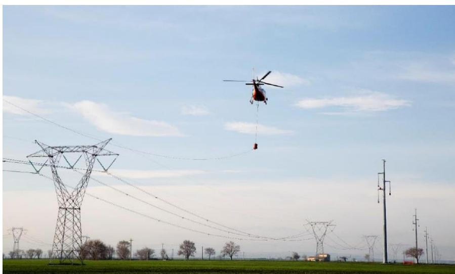
**Figura 2-15 utilizzo dell'elicottero per la stesura della fune pilota**
