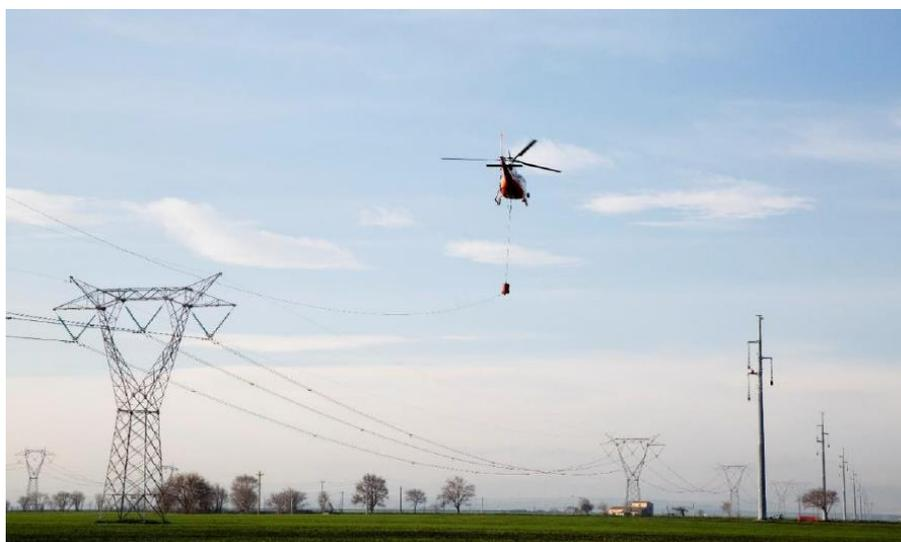
**Figura 3-11 utilizzo dell'elicottero per la stesura della fune pilota**
