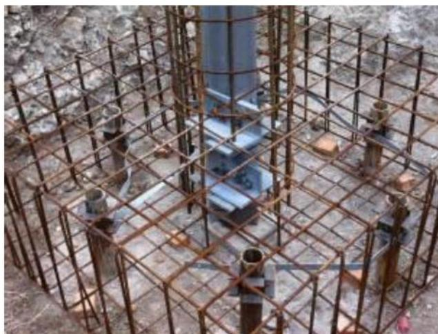
**Figura 3-9 Esempio di realizzazione di una fondazione su micropali tipo tubfix**
