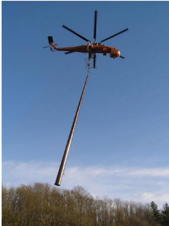
**Figura 3-10 Esempio di trasporto di un sostegno con elicottero (tipo Erickson)**
