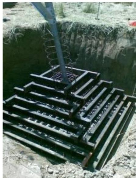
**Figura 3-4 Esempio di realizzazione di una fondazione a plinto con riseghe. Nell'immagine di sinistra di può osservare un disegno di progetto mentre nell'immagine di destra la fase di cassetatura della fondazione**
