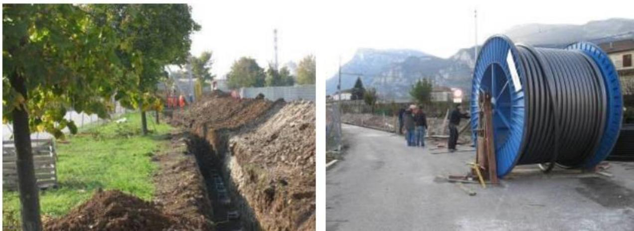
**Figura 3-15 Esempi di posizionamento della bobina contenente il cavo**
