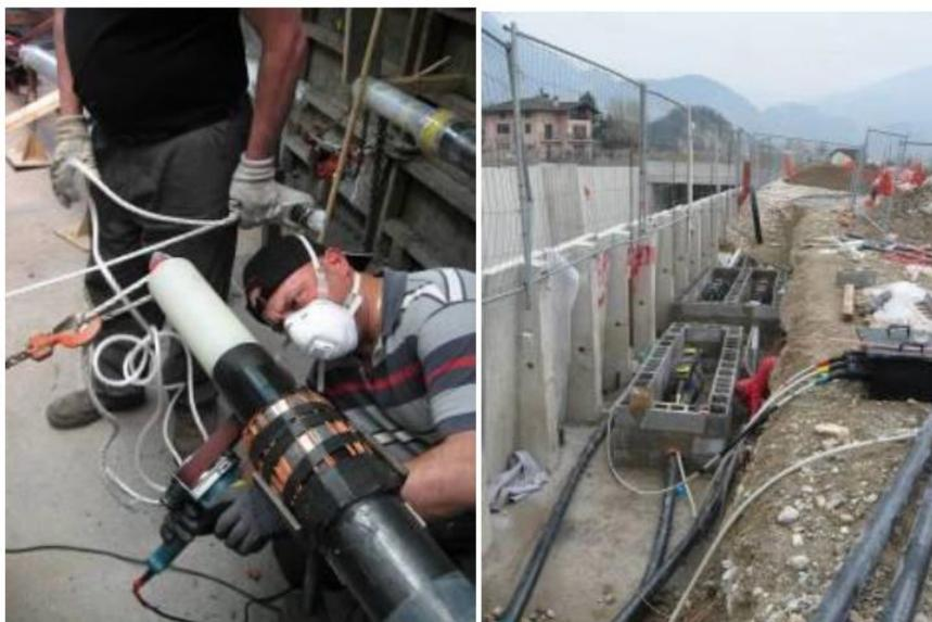
**Figura 3-16 Esempio di esecuzione buca giunti**
