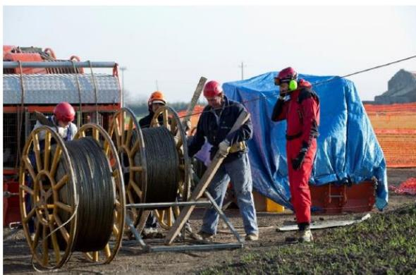
**Figura 3-12 Fasi di tesatura della linea elettrica**
