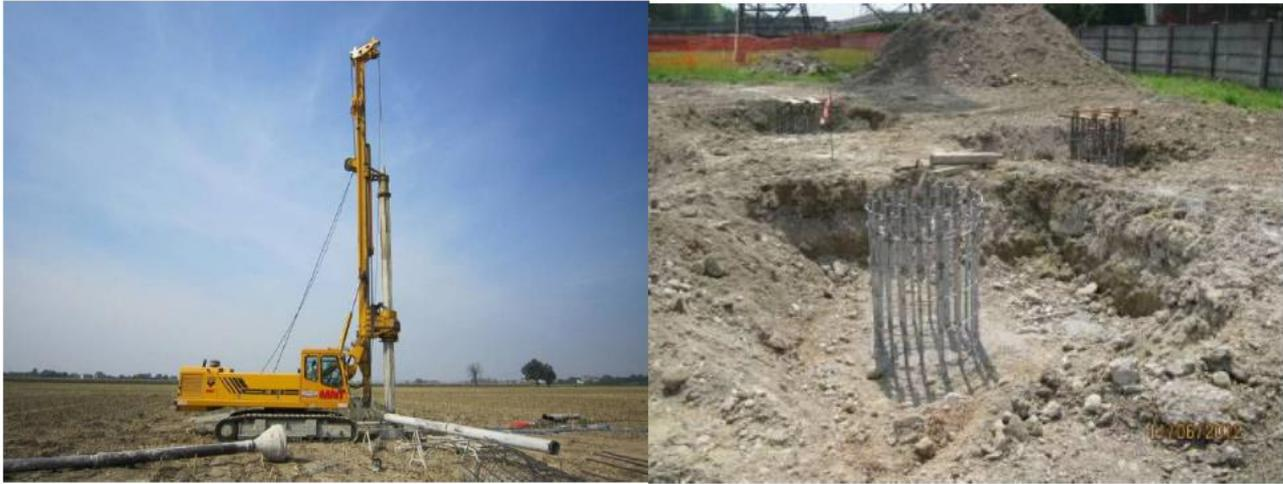
**Figura 3-7 Macchina operatrice per la realizzazione di pali trivellati**
