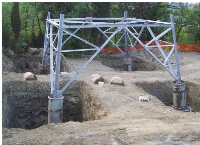
**Figura 3-5 Realizzazione di fondazioni superficiali tipo CR per un sostegno a traliccio, con le quattro buche, la base del sostegno collegata alla fondazione tramite monconi ed i casseri utilizzati per i quattro colonnini**
