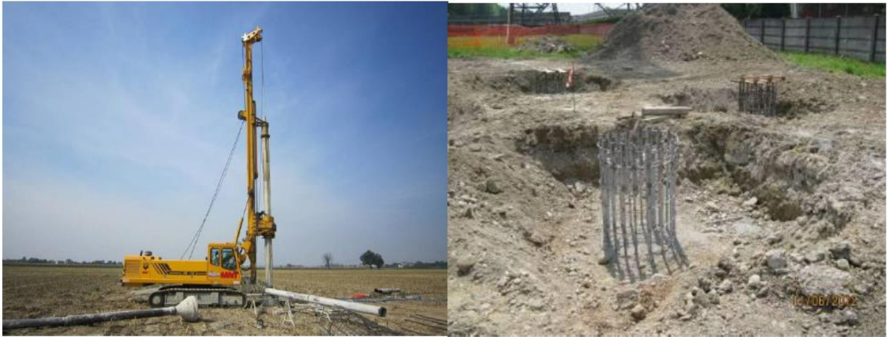
Figura 2-10 Macchina operatrice per la realizzazione di pali trivellati
