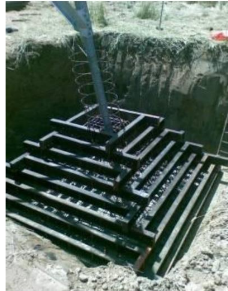
Figura 2-7 Esempio di realizzazione di una fondazione a plinto con riseghe. Nell'immagine di sinistra di può osservare un disegno di progetto mentre nell'immagine di destra la fase di casseratura della fondazione
