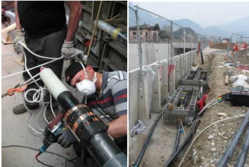
Figura 2-19 Esempio di esecuzione buca giunti
