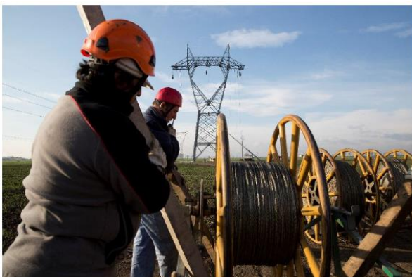
Figura 2-15 Fasi di tesatura della linea elettrica
