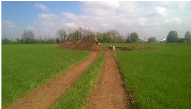
Figura 2-20 Esempio di pista temporanea su terreno agricolo
