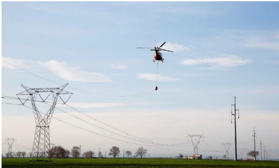
Figura 2-14 utilizzo dell'elicottero per la stesura della fune pilota
