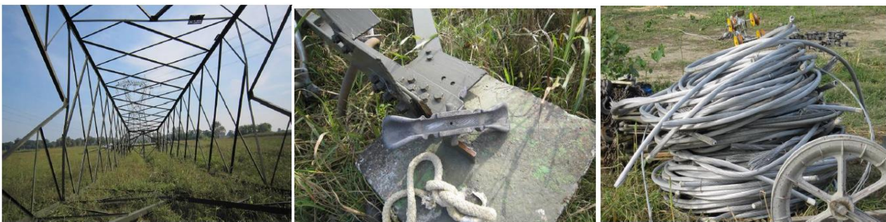
Figura 2-21 Fasi di demolizione di un sostegno a traliccio
