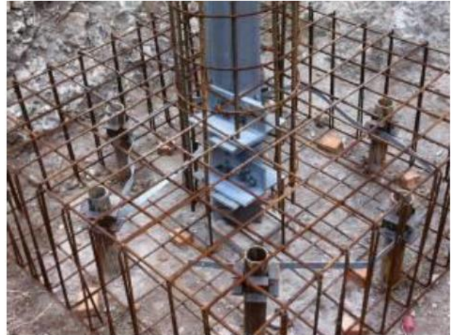
Figura 2-12 Esempio di realizzazione di una fondazione su micropali tipo tubfix
