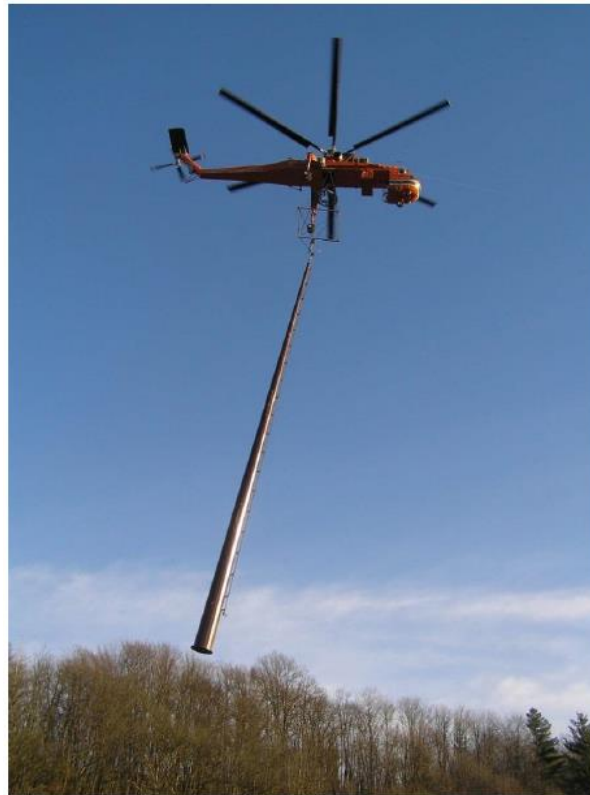
Figura 2-13 Esempio di trasporto di un sostegno con elicottero (tipo Erickson)
