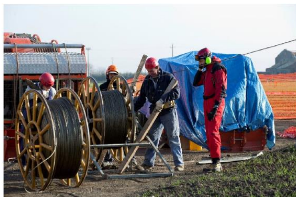
Figura 2-15 Fasi di tesatura della linea elettrica
