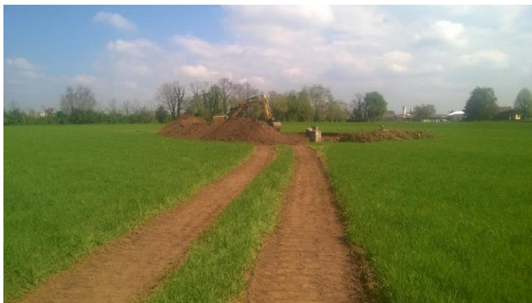
Figura 2-20 Esempio di pista btemporanea su terreno agricolo
