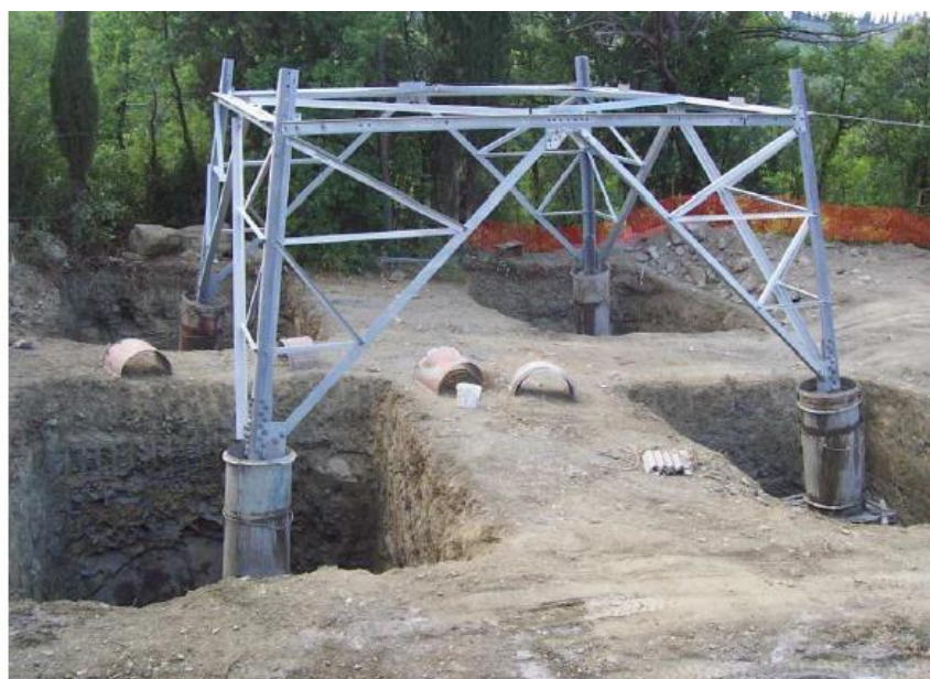
Figura 2-8 Realizzazione di fondazioni superficiali tipo CR per un sostegno a traliccio, con le quattro buche, la base del sostegno collegata alla fondazione tramite monconi ed i casseri utilizzati per i quattro colonnini
