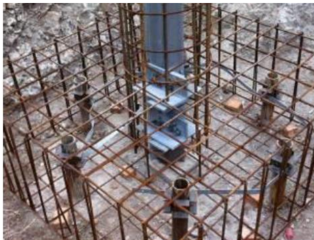
Figura 2-12 Esempio di realizzazione di una fondazione su micropali tipo tubfix
