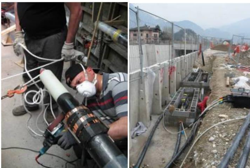
Figura 2-19 Esempio di esecuzione buca giunti
