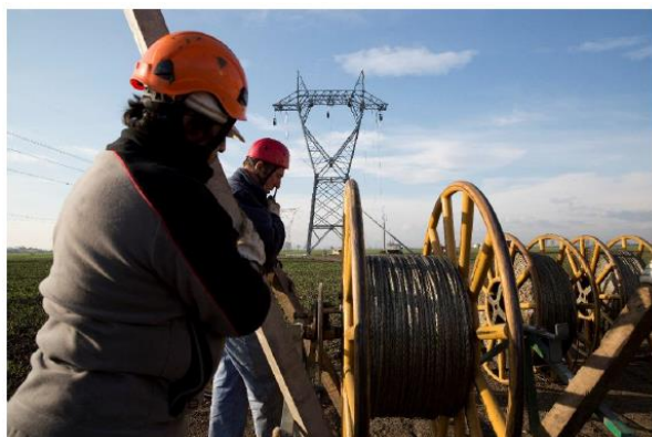
Figura 2-15 Fasi di tesatura della linea elettrica
