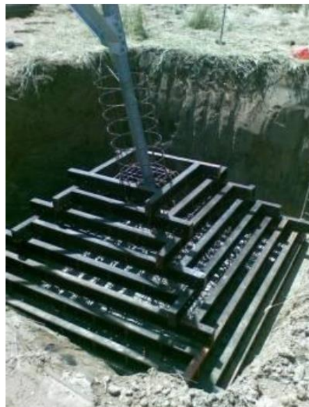
Figura 3-7 Esempio di realizzazione di una fondazione a plinto con riseghe. Nell'immagine di sinistra di può osservare un disegno di progetto mentre nell'immagine di destra la fase di casseratura della fondazione
