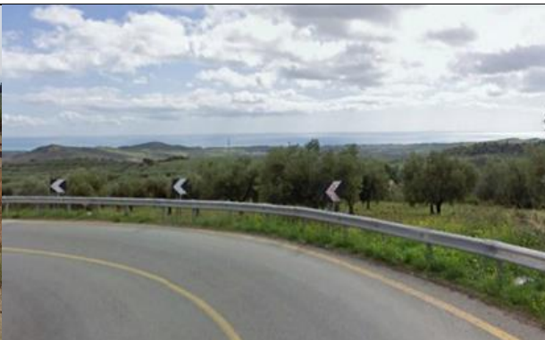
Figura 6-21: Vista ravvicinata, dalla SS180, in direzione dell'intervento (sostegno P.25)
