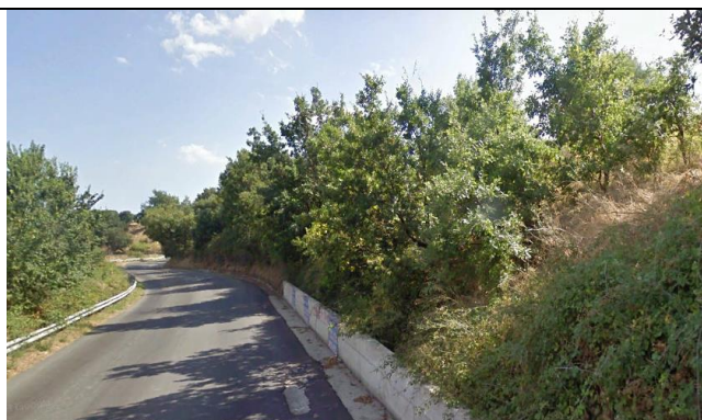
Figura 6-16: Vista dalla SS109 ter attraversata dal progetto in corrispondenza del sostegno P.31
