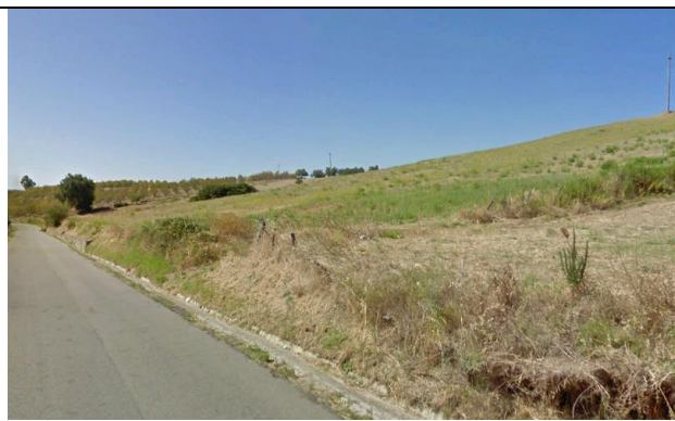
Figura 6-23: Vista dalla strada provinciale Cuccuma – Mortilla, in direzione dell'intervento (sostegno P.37)
