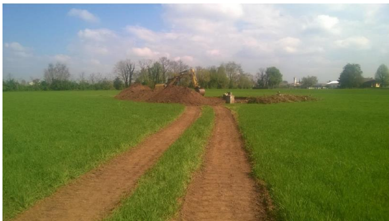
Figura 3-20 Esempio di pista btemporanea su terreno agricolo
