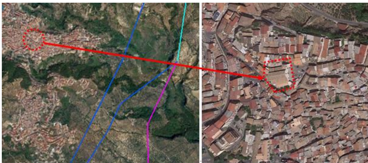
Figura 5-86: Ubicazione rispetto al tracciato dell'elettrodotto in progetto, perimetrazione e foto dell'arcipretale dell'Annunziata
