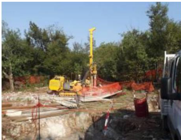
Figura 3-12 Esempio di realizzazione di una fondazione su micropali tipo tubfix
