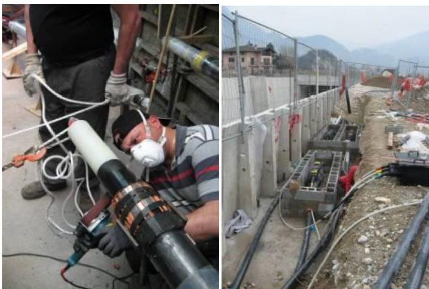
Figura 3-19 Esempio di esecuzione buca giunti
