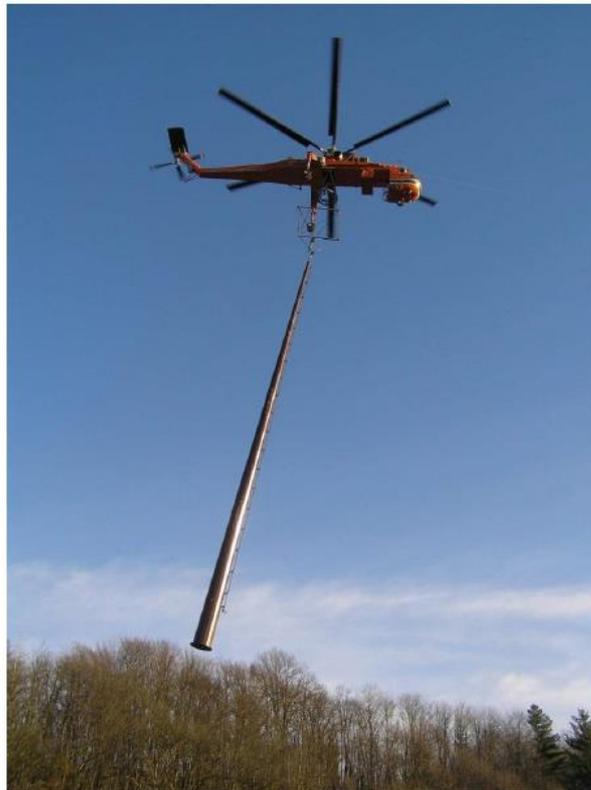
*Figura 4-13 Esempio di trasporto di un sostegno con elicottero (tipo Erickson)*
