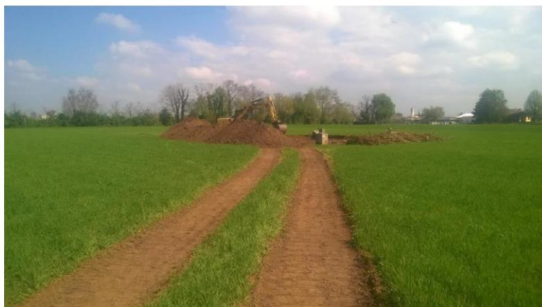
*Figura 4-20 Esempio di pista temporanea su terreno agricolo*
