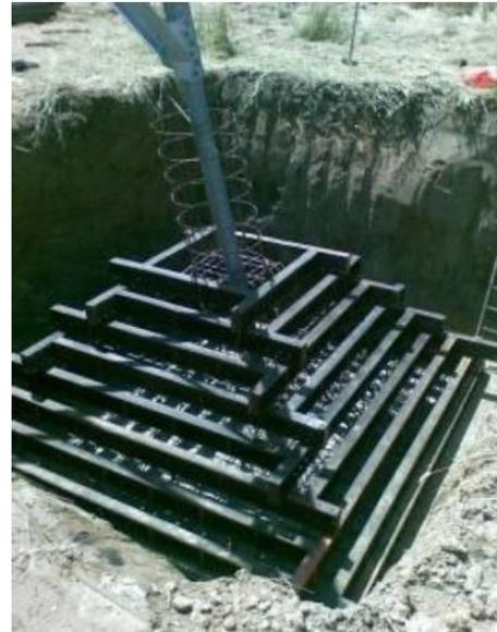
*Figura 4-7 Esempio di realizzazione di una fondazione a plinto con riseghe. Nell'immagine di sinistra di può osservare un disegno di progetto mentre nell'immagine di destra la fase di casseratura della fondazione*
