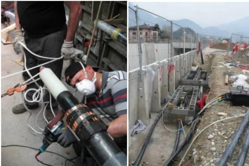
*Figura 4-19 Esempio di esecuzione buca giunti*
