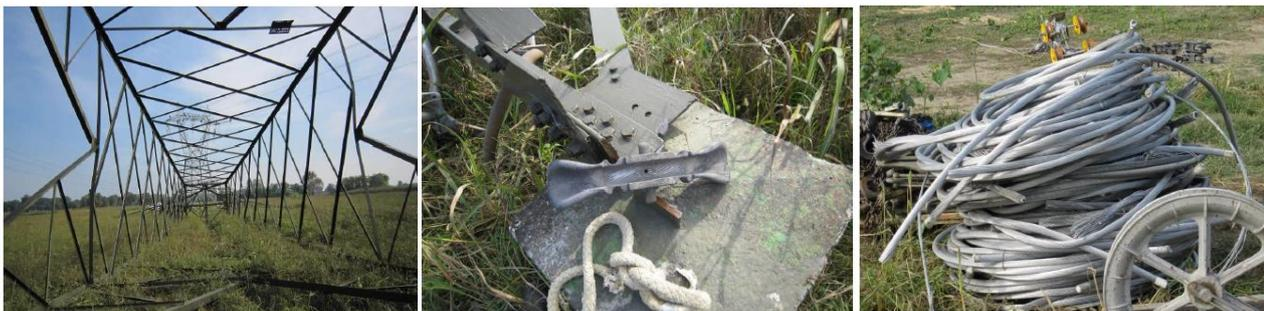
*Figura 4-21 Fasi di demolizione di un sostegno a traliccio*
