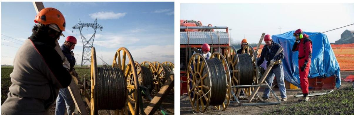
*Figura 4-15 Fasi di tesatura della linea elettrica*
