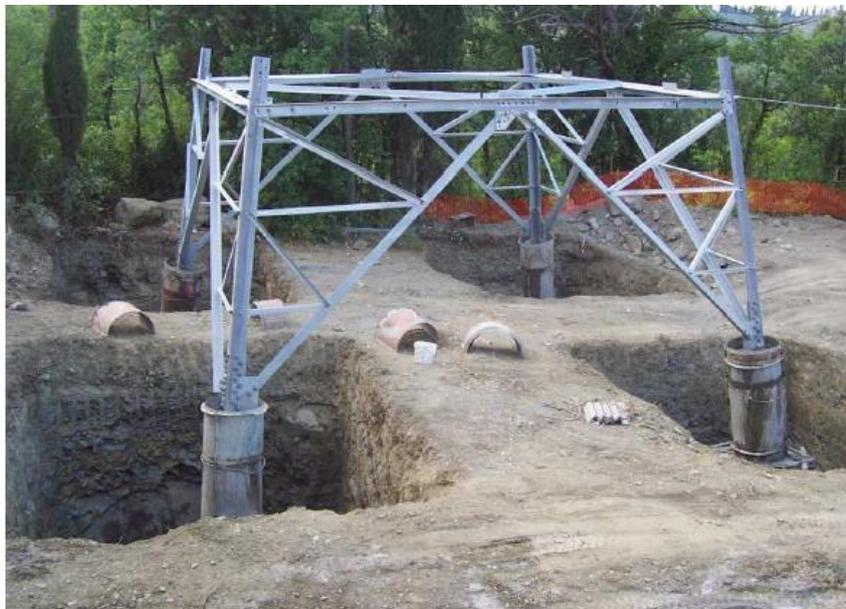
*Figura 4-8 Realizzazione di fondazioni superficiali tipo CR per un sostegno a traliccio, con le quattro buche, la base del sostegno collegata alla fondazione tramite monconi ed i casseri utilizzati per i quattro colonnini*
