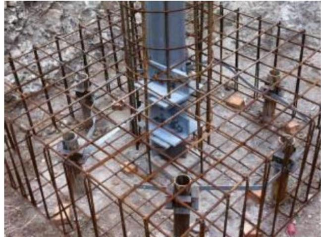
*Figura 4-12 Esempio di realizzazione di una fondazione su micropali tipo tubfix*
