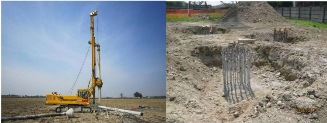
*Figura 4-10 Macchina operatrice per la realizzazione di pali trivellati*
