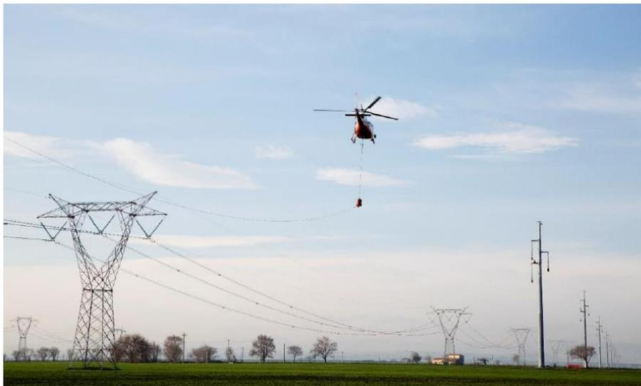
*Figura 4-14 utilizzo dell’elicottero per la stesura della fune pilota*
