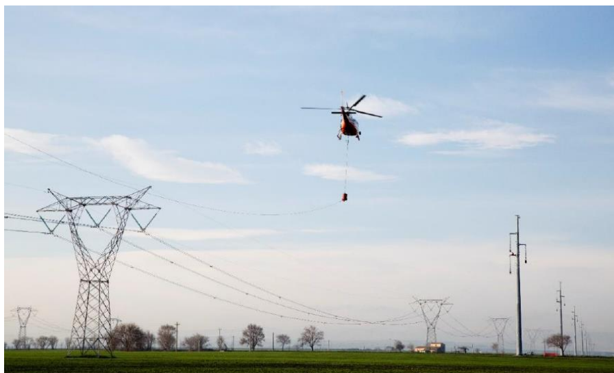
Figura 3-3 utilizzo dell'elicottero per la stesura della fune pilota
