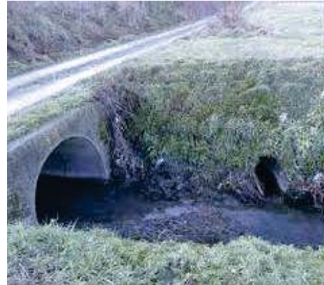
Figura 11 - Rappresentazione grafica del tombino circolare in cemento armato
