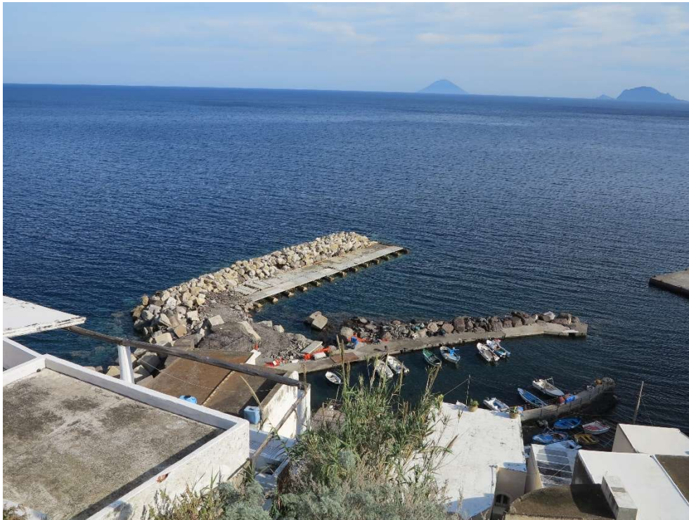
Figura 1 - Situazione delle opere realizzate incompiute a 11/2012 prima della rescissione contrattuale
