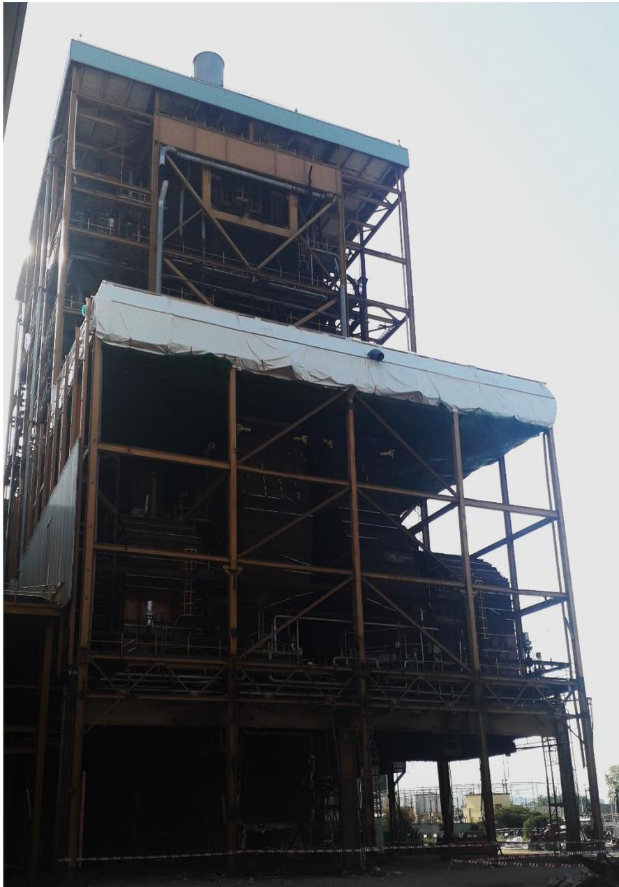
**Foto 2 – Confinamento dinamico sopra il solaio riscaldatori aria Gruppo 4**
