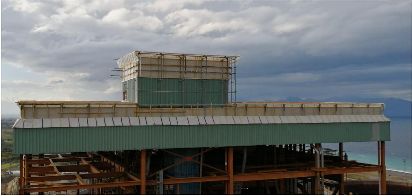
**Foto 5 – Predisposizione confinamento dinamico sopra tetto caldaia Gruppo 4**
