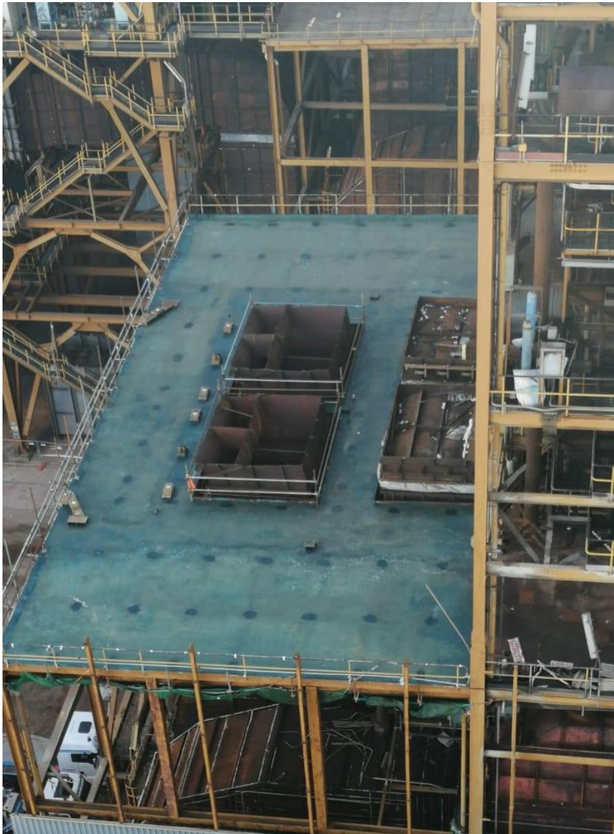
**Foto 3 – Solaio sopra riscaldatori aria, post bonifica e smontaggio area confinata**
