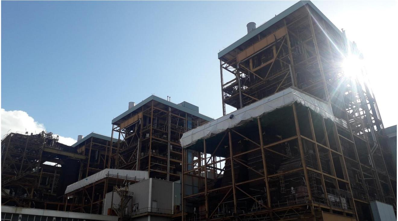
**Foto 1 – Confinamenti dinamici sopra i due solai riscaldatori aria Gruppi 3 e 4**
