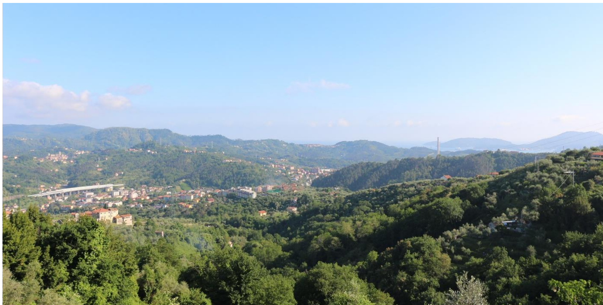
Figura 5.4.15 – Punto di vista 6 – Stato di fatto
