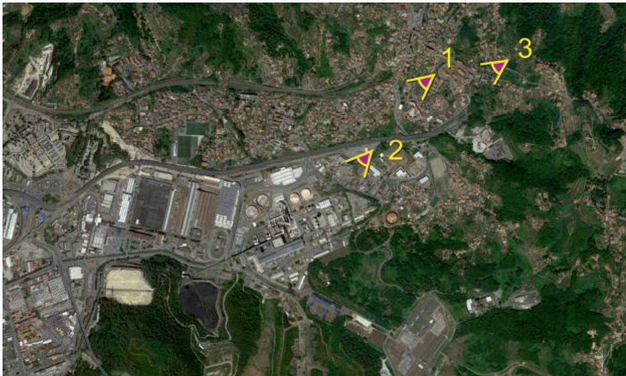
Figura 5.4.1 - Localizzazione del punto di vista 1
