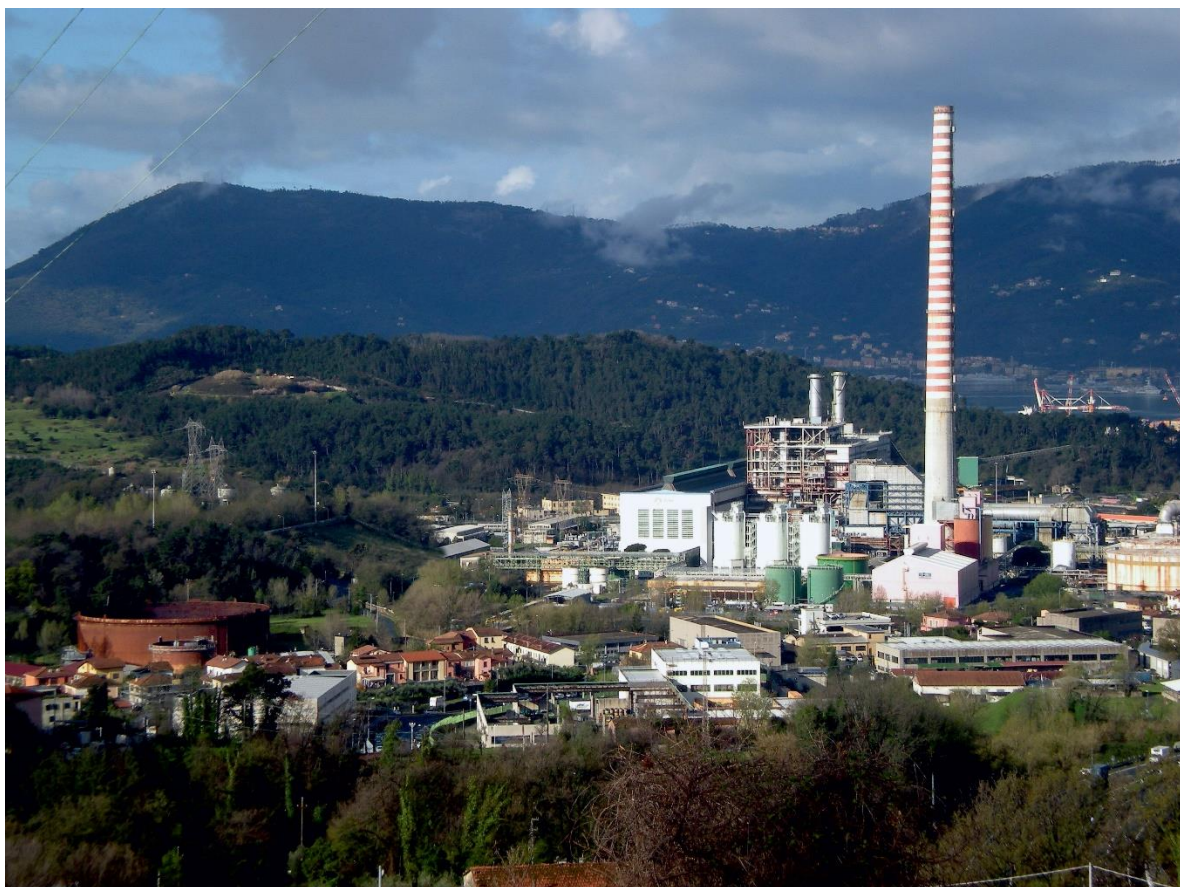
Figura 2.1.1 – Vista della Centrale “Eugenio Montale” a La Spezia
