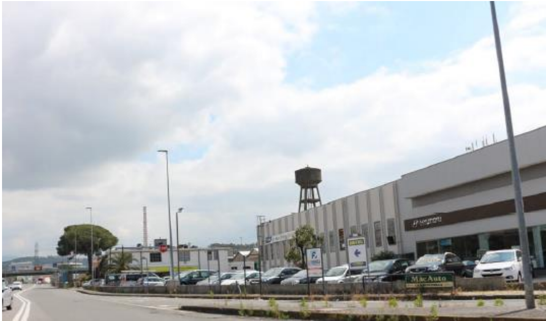
Figura 6.7.3 – Aree industriali nei dintorni della Centrale
