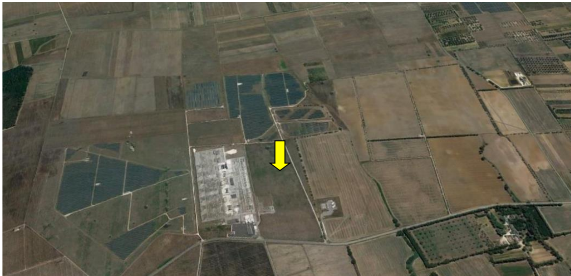
AREA S. E. TERNA BRINDISI SUD POSIZIONE SOTTO STAZIONE DA REALIZZARE
