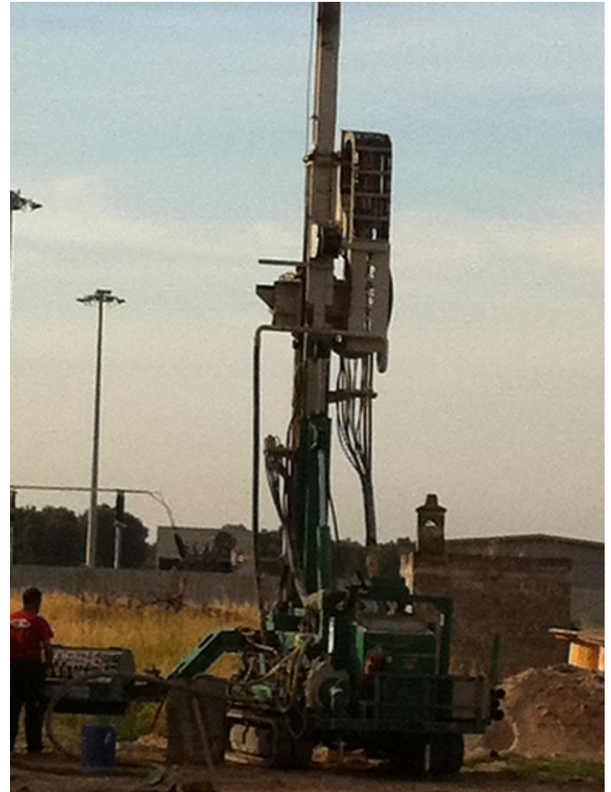
Sondaggio a carotaggio continuo eseguito dallo scrivente presso la CPR TERNA di S.Donaci nei pressi di Via Mesagne.
