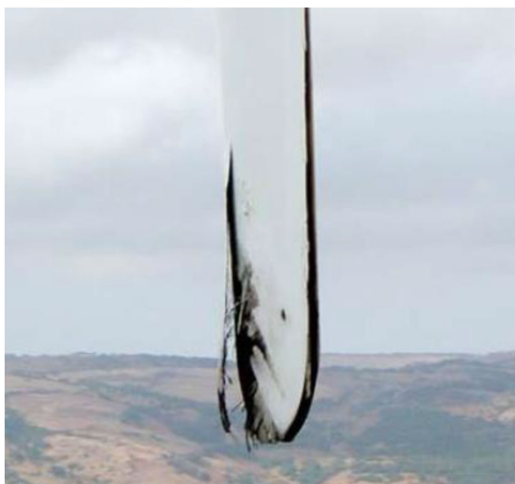
Figura 1 - Estremità della pala danneggiata da fulminazione atmosferica
